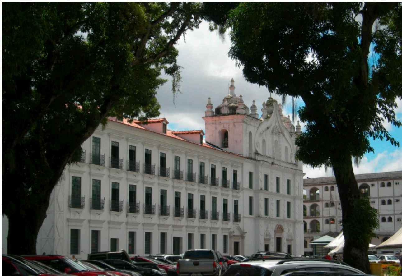
Dois aspectos da fachada da Igreja de Santo Alexandre na Cidade Velha de Belém do Pará (Brasil). A Igreja e o Colégio foram a sede da Companhia de Jesus em Belém na época do Brasil colônia. (Foto Wolf Dietrich).
