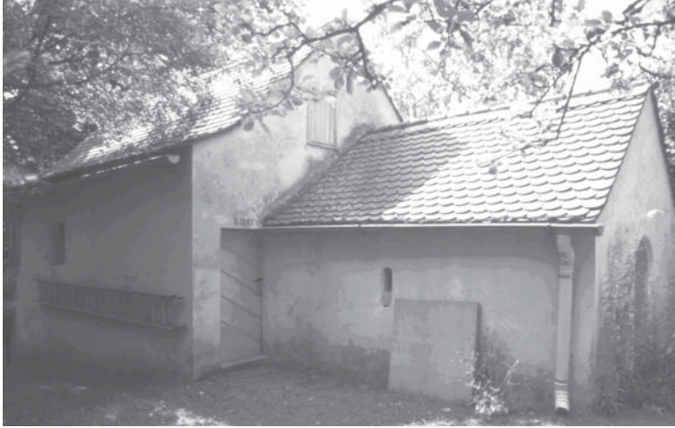
ABB.: 2 TAHARAHÄUSER IN ZECKERN (BAYERN): IM RECHTS DAS URSPRÜNGLICHE TAHARAHÄUSER (UM 1710), LINKS DAHINTER DIE ERWEITERUNG UM EIN WÄCHTERWOHNHAUS VON 1893 (FOTO: KNUFINKE 2001)
