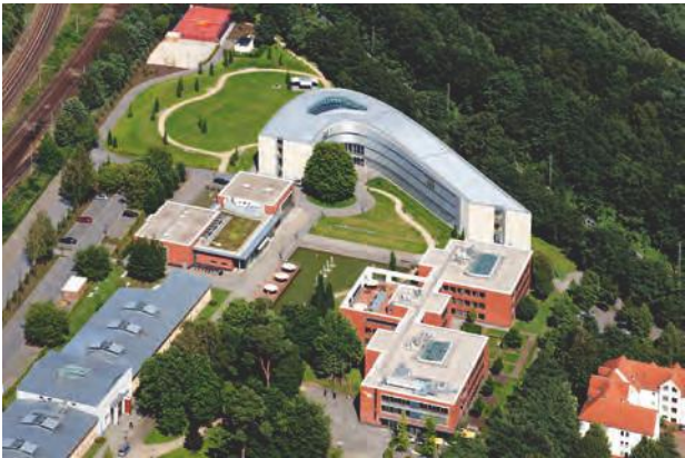
Luftbildaufnahme des HPI Campus I, 2011.
