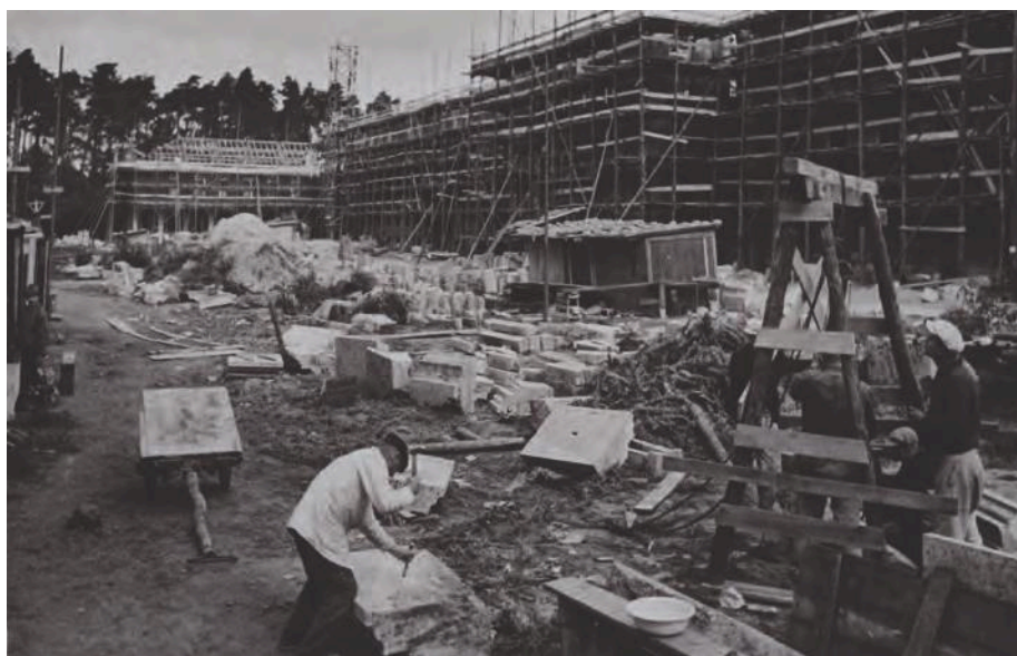
Baustelle des DRK-Präsidiums kurz vor dem Richtfest, 1940.
