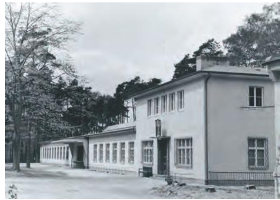
Das Sanitätslager mit dem Hoheitszeichen des DRK über dem Eingang. Das Gebäude wurde noch bis in die 2000er Jahre hinein als Archiv des Filmmuseums, der Universität und als ZEIK genutzt, musste dann aber einer Buswendestelle weichen.
