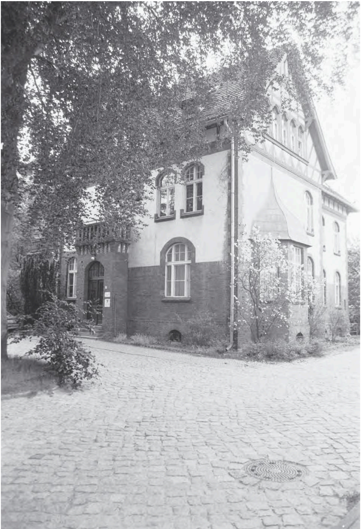
Gebäude der Abteilung Weltwirtschaft des IIB sowie der Übersetzerabteilung der Akademie (heute: Haus 2).
