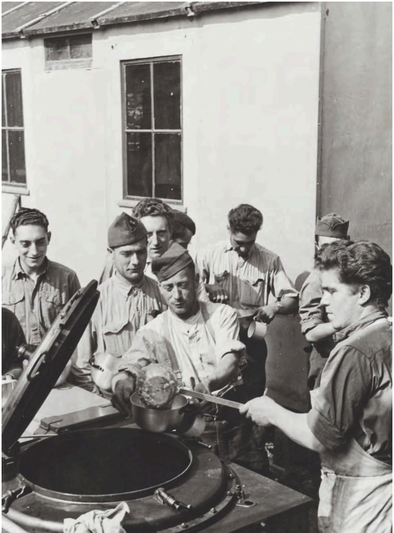
Nicht namentlich bekannte Kriegsgefangene mehrerer Nationen wurden beim Bau des DRK-Präsidioms als Zwangsarbeiter eingesetzt. Das für Propagandazwecke aufgenommene Foto zeigt ihre Versorgung im eigens dafür eingerichteten Lager nahe der Baustelle, 1940.
