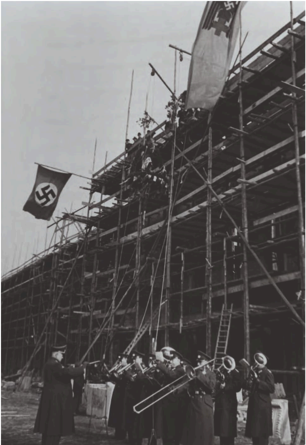
Richtfest auf der Baustelle des DRK-Präsidentengebäudes, 28. Oktober 1940.
