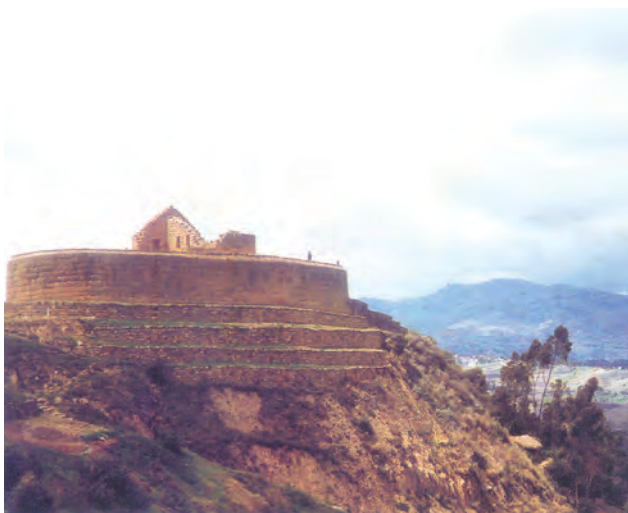
Abb. 2. Heutiger Zustand der Inkafestung Ingapirca bei Cañar in Ecuador. Humboldt hat die Festung in den „Vues des Cordillères“ pl. 17 (Monument péruvien du Cañar), abgebildet. (Foto: Margot Faak)
