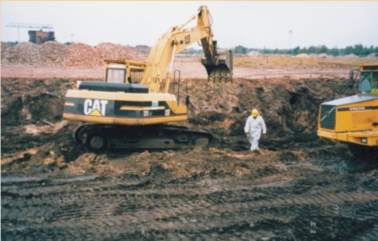
Sanierungsarbeiten auf dem Gelände der Kokerei Lauchhammer, Baugrube in einem Quecksilberkontaminierten hot spot, Schwarzbereich, 1999
