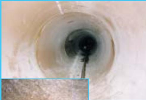
◀ **Gubener Straße DN 900 Montageverfahren Kurzrohrrelining mit GFK-Rohren**
