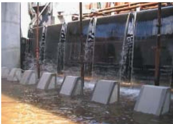
**Bild 4: Probetrieb Verschlüsse und Tosbecken im linken Wehrfeld, D. Günther**
