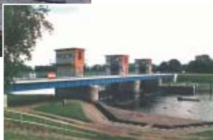
aufgesetzter, in aufrechter Stellung 1,40 m hoher Fischbauchklappe gewählt. Dabei soll der Wasserstand in der Regelfahrweise mittels der überströmten Klappen feinregulierbar und vorrangig automatisch gesteuert werden. Die unterströmte Fahrweise soll in Zukunft die Ausnahme bleiben.
