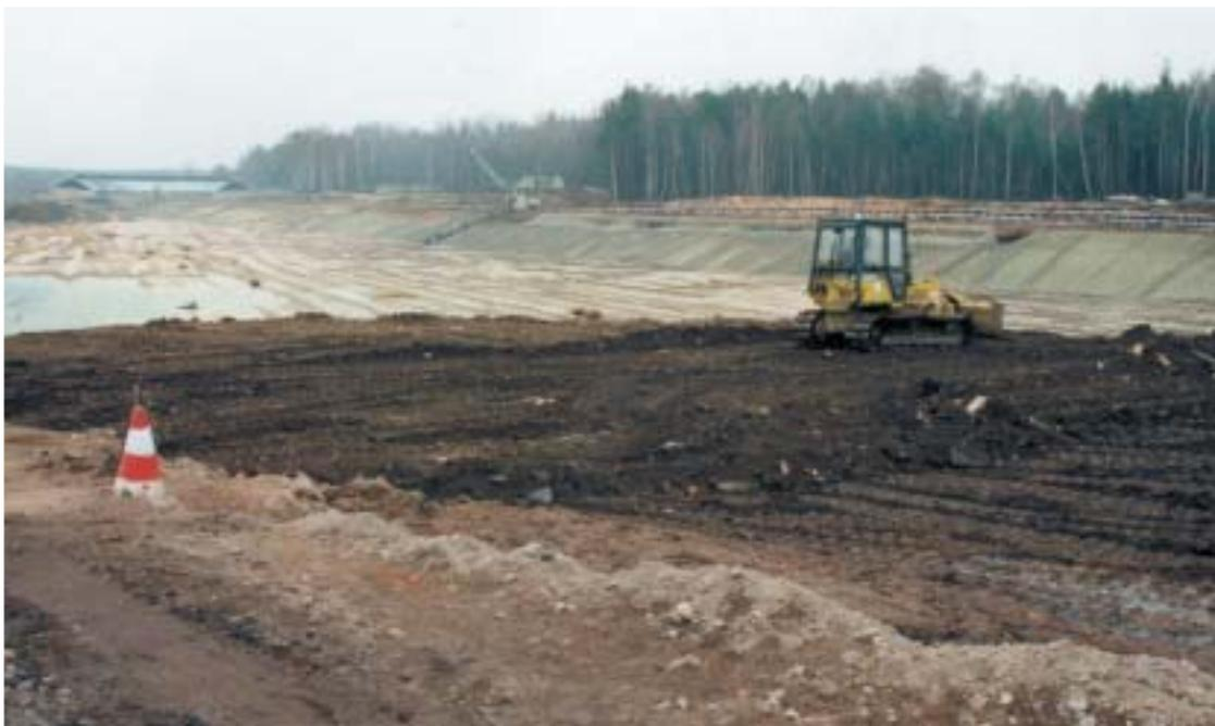
**Wiedernutzbarmachungsarbeiten im Tontagebau Plessa (Verfüllung mit Bodenaushub)**
