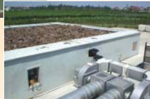
**Abb. 2: Geschlossener Biofilter (Quelle: Tholander Ablufttechnik GmbH)**
