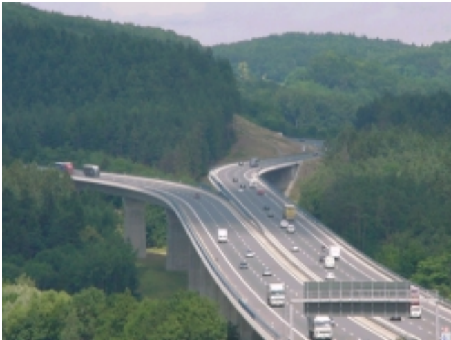
Sechsstreifiger Ausbau der BAB A9 vom AD Potsdam bis AK Nürnberg (Zustand nach dem Ausbau)
