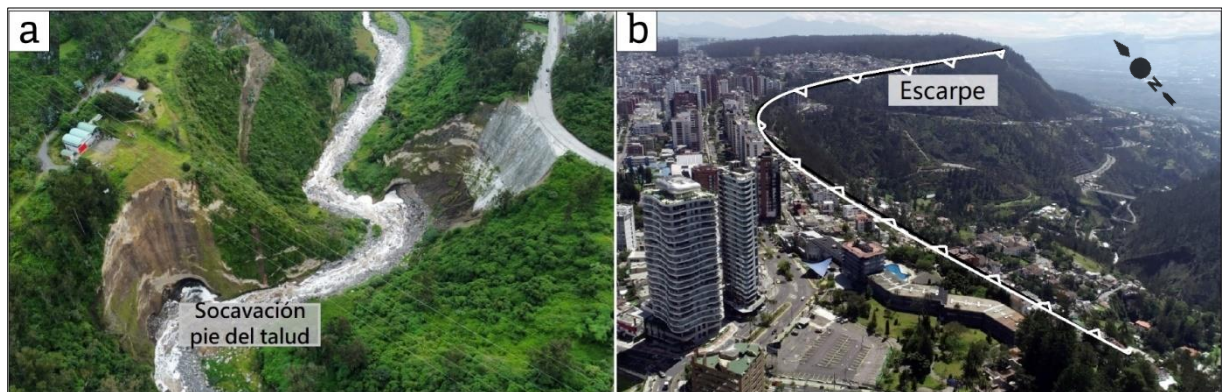
Fig. 4.7. a) Proceso de erosión y socavación de los taludes aguas abajo del río Machángara. b) Escarpe semicircular en línea blanca del MM-2 Batán, foto tomada con dron, proyecto Tomorrow's Cities 2020.
