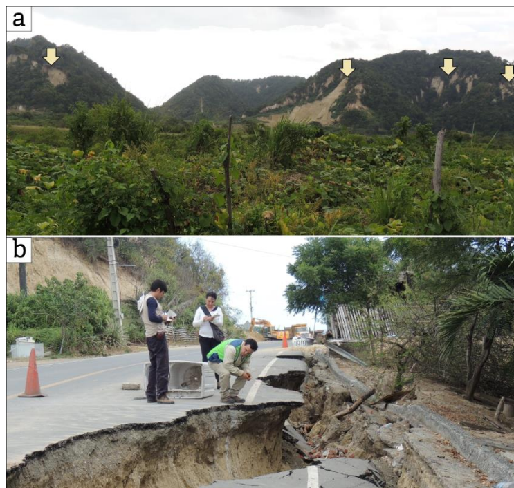
Fig. 1.7. a) Las flechas muestran las zonas afectadas por una serie de derrumbes en las laderas de los cerros costeros vía a San Clemente, b) daños en la red vial en la zona de San Isidro (fotografías Departamento de Geología, Villares et al. 2016)
