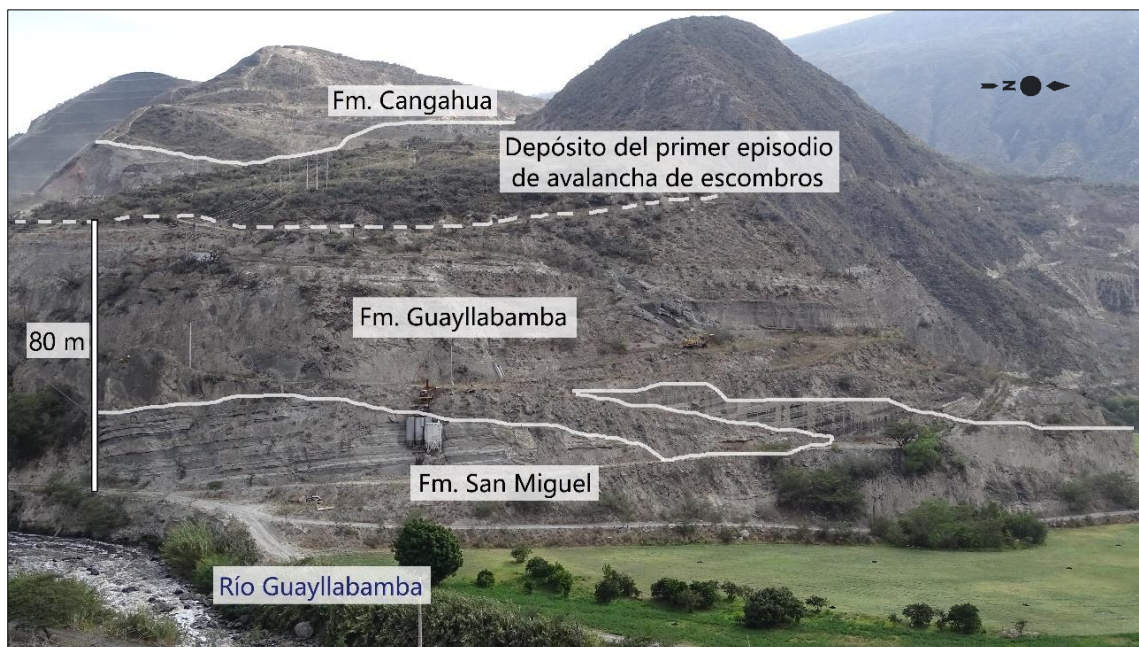
Fig. 5.10. Secuencia estratigráfica completa que aflora en el flanco oriental del pliegue SE del anticlinal de Bellavista-Catequilla, al sur del MM-4 San Francisco. Se observa el descenso del nivel base de la parte norte de la cuenca, en una segunda fase de incisión fluvial del río Guayllabamba.
