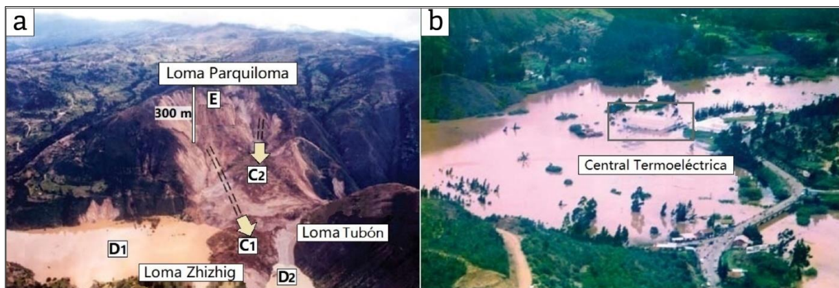
Fig. 1.4. a) Deslizamiento y represamiento de La Josefina en 1993: E escarpe, C1 y C2 indican la dirección de los depósitos del primer y segundo colapsos, D1 y D2 muestran los embalses, b) Inundación de los poblados y la central termoeléctrica (en recuadro) a 2 km aguas arriba del represamiento (tomada de PMA: GCA. 2007)
