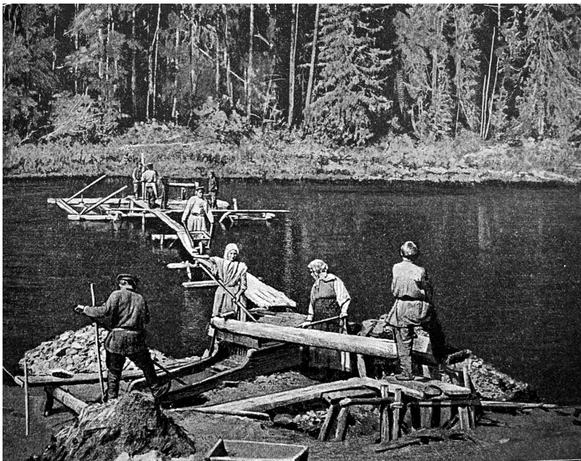
Abb. 6: Goldseifenbaggerung und Waschherd-Verfahren am Ural (Foto um 1870, aus Berdrow 1901, S. 221, Abb. 191).
