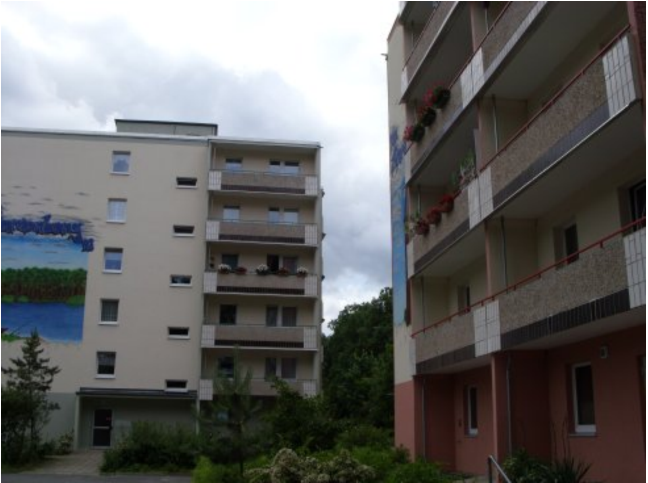
Fig. 5: Die Bauten am nördlichen Rand des Wohngebiets sind für ältere Einwohner konzipiert und mit Fahrstühlen versehen. Foto: MW
