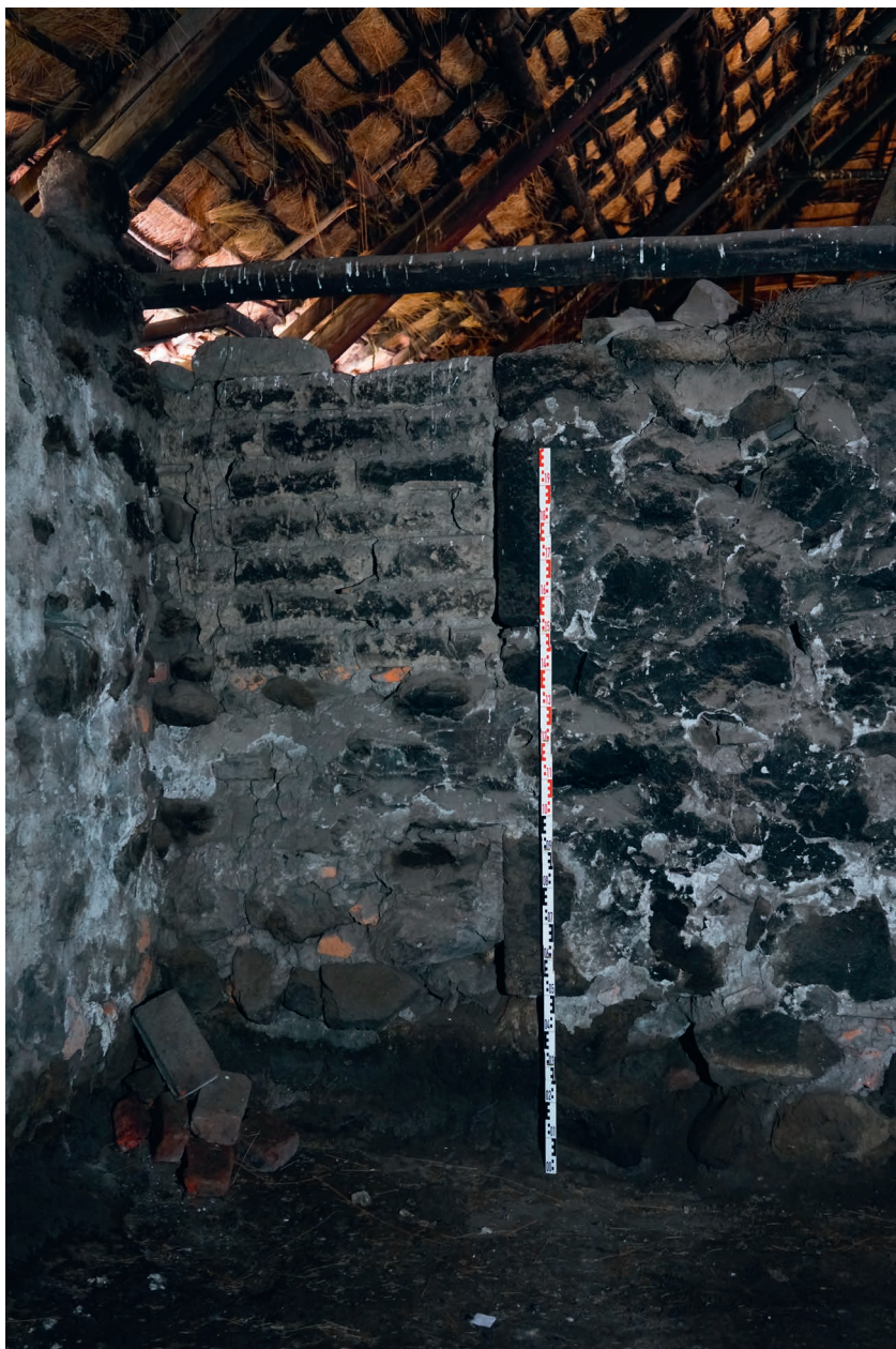
Abb. 5: Befundfoto einer zugesetzten Tür zwischen R. 0.5 und 0.6, 2019 (Nöbauer).
