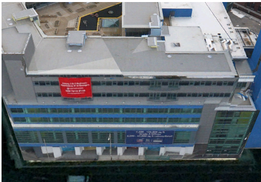
(a) Ohne Farbausgleich: Einzelne Flächen (z. B. Dach) enthalten deutliche Farbunterschiede.
