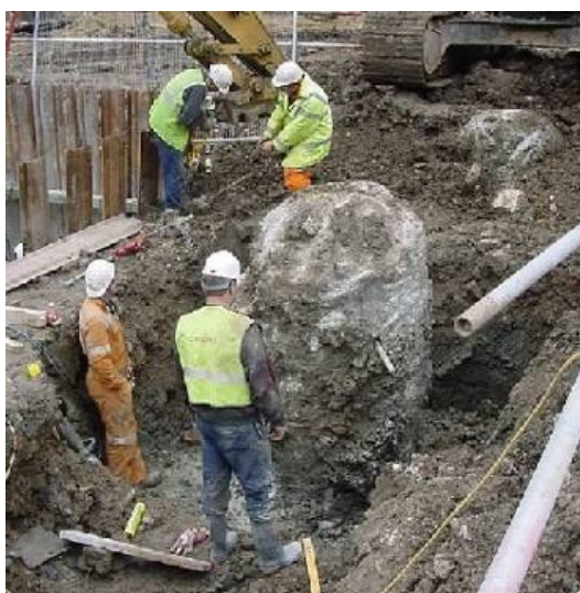
Abbildung 1.1: "Would you re-use this?": Freilegen eines Fundamentpfahles beim Gebäudeabriss. Foto: BRE, 2004.
