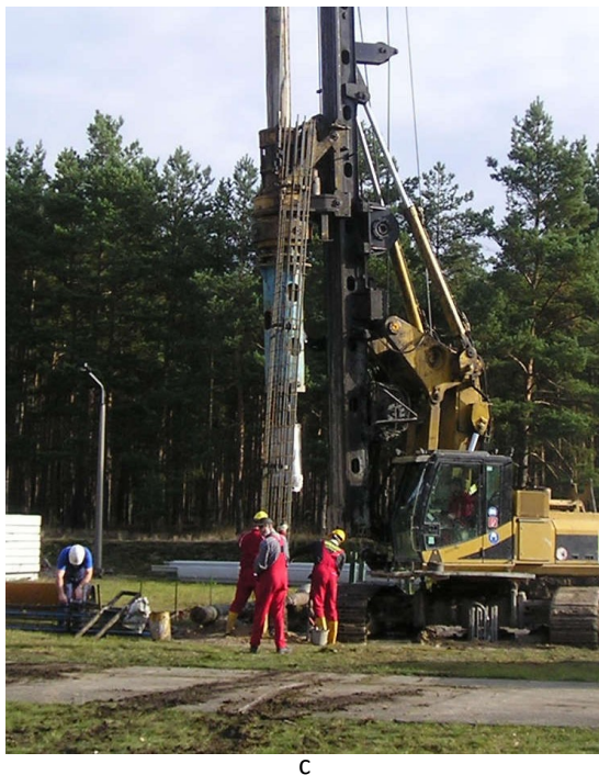
Abbildung 2.5: Herstellung der Bohrpfähle auf dem BAM-Testgelände Technische Sicherheit in Horstwalde. A: Bohren mit Kellystange im Rohr, b: Bohrwerkzeuge (Schnecke und Eimer), c: Einsetzen des Bewehrungskorbes, d: Einführen des Schüttrohres zum Betonieren.
