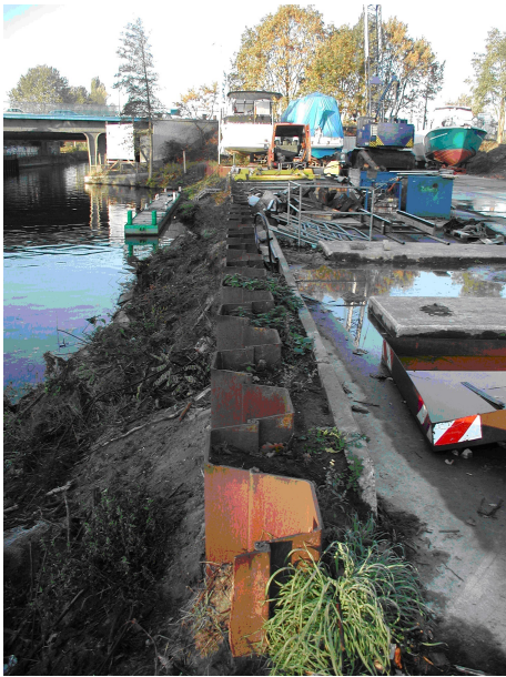
Abbildung E.1: Spundwand auf dem Gelände der Firma Hollandboot. Links: Übersicht. Rechts: Detail mit Bohrloch und Parallel-Seismik-Sensorkabel
