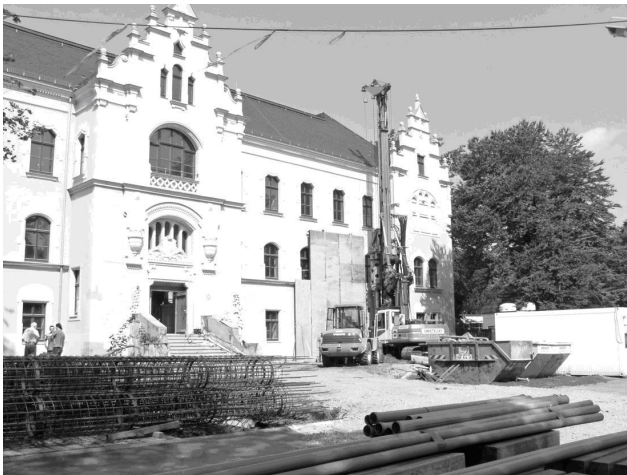
Abbildung E.10 (oben): Baustelle in Grimma.
