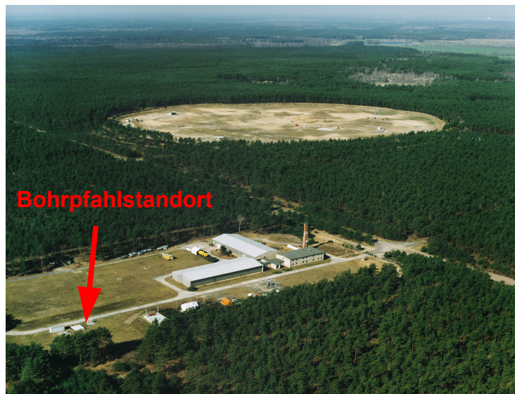
Abbildung D.2: BAM Testgelände Technische Sicherheit Horstwalde (TTS) (Luftbild: BAM, Aufnahme vor Herstellung Bohrspfähle)
