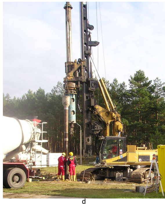
Abbildung 2.5: Herstellung der Bohrpfähle auf dem BAM-Testgelände Technische Sicherheit in Horstwalde. A: Bohren mit Kellystange im Rohr, b: Bohrwerkzeuge (Schnecke und Eimer), c: Einsetzen des Bewehrungskorbes, d: Einführen des Schüttrohres zum Betonieren.
