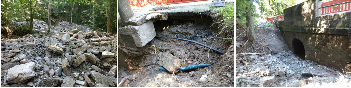
Abbildung 12: Abflusskanal des aus Südosten her einmündenden Zuflusses zum Orlacher Bach, mit Murgang-ähnlichen Ablagerungen oberhalb der Straße (linkes Bild).
