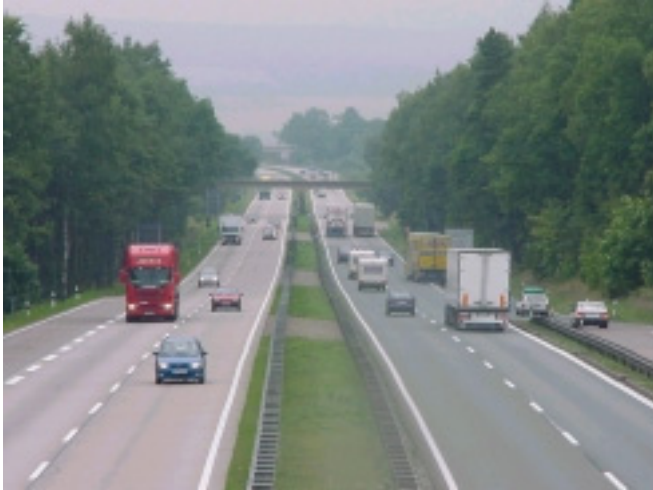
Sechsstreifiger Ausbau der BAB A9 vom AD Potsdam bis AK Nürnberg (Zustand vor dem Ausbau)
