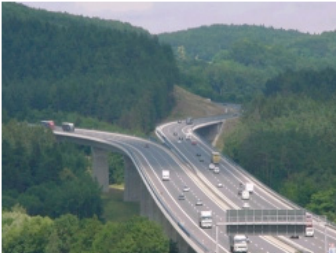
Sechsstreifiger Ausbau der BAB A9 vom AD Potsdam bis AK Nürnberg (Zustand nach dem Ausbau)
