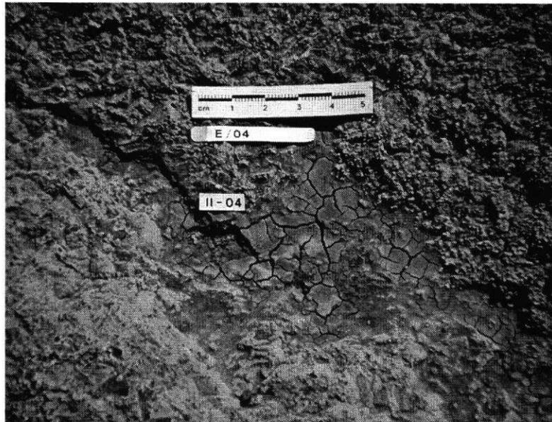
Foto E/04 **Westecke, Aufnahme von oben, ca. 150 cm von unten**; dicke, blumenkohlartige, körnige Ablagerung auf der ganzen Fläche (Bruchstelle), in den Vertiefungen Nilschlamm in großen Mengen (Wasserspeicher, Schrumpfung, biologische Besiedlung).
