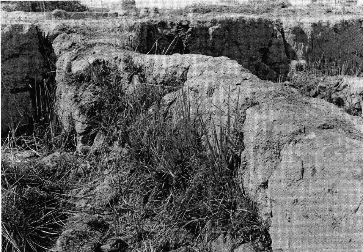
Abb. 9: Zerstörungen des Mauerwerks durch Halfgras (2000)
