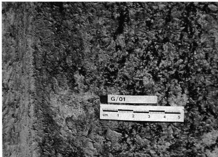
Foto G/01 **Südwestseite, ca. 80 cm vom Boden**; Salzausblühungen (weise Spuren), die Politur ist hier nicht mehr erhalten, die Oberfläche ist matt aber noch erkennbar, einige Kristalle hell erscheinend, sehr kleine Ausbrüche, in der Vertiefung zwischen den Bündelelementen stark an der Oberfläche haftender Nilschlamm, im Vergleich zu frischen Bruchstellen dunkler und stumpfer wirkende Farben, leichte Rostfärbung.
