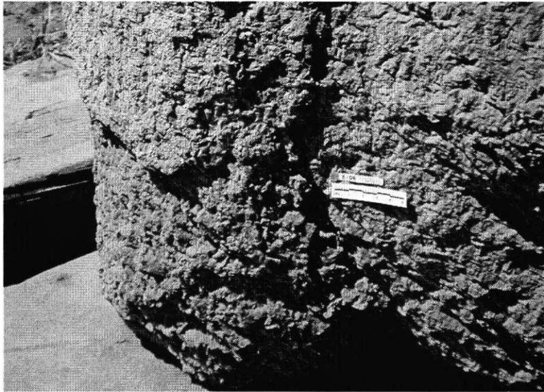
Foto E/06 **Ostseite, unten, verwitterter unterer** Abschluß des Bündelelements, die Kante steht direkt auf der Betonplatte (statisch bedingter Riß); dabei typische Schadensbilder – Abbröckeln, Schalenbildung, Nilstaub).
