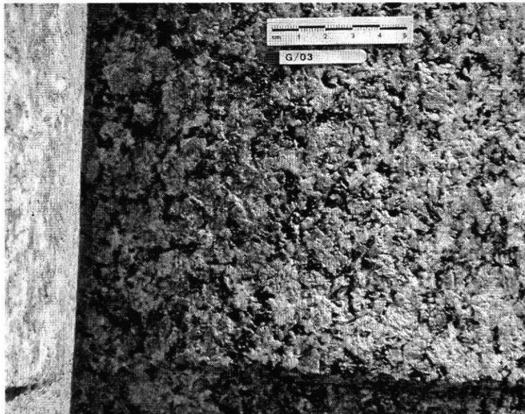
Foto G/03 **Westseite, ca. 90 cm von unten**, relativ gut erhaltene Oberfläche, sehr tief ausgewitterte Biotit-Komponenten (Vertiefungen 1 mm an manchen Stellen bis 2 mm); sehr locker haltende Kristalle, in dem Oberflächenbereich stark zertrümmert – Feldspatkristalle (längs verlaufende Risse), Quarzkristalle (heller erscheinende Bereiche).
