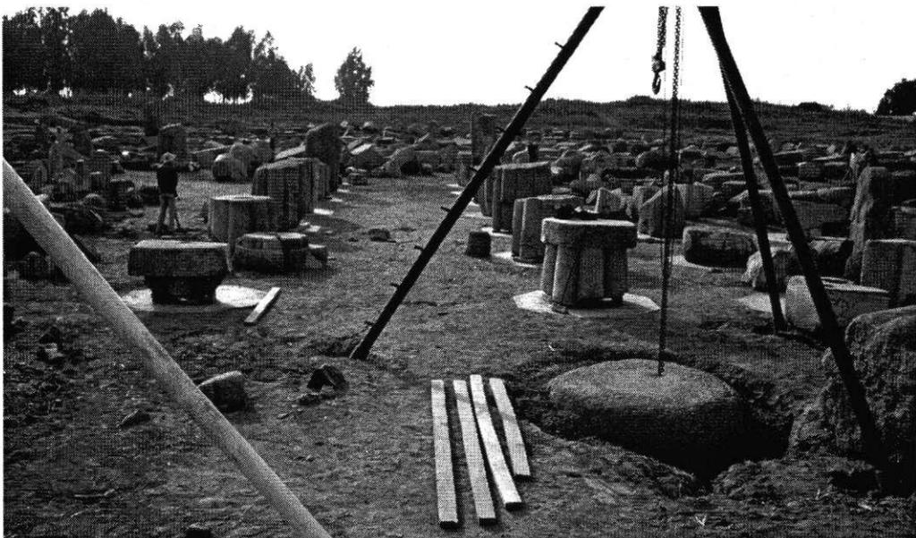
Abb. 19: Zurücksetzen eines Fundamentsteins aus Rosengranit in seine ursprüngliche Lage
