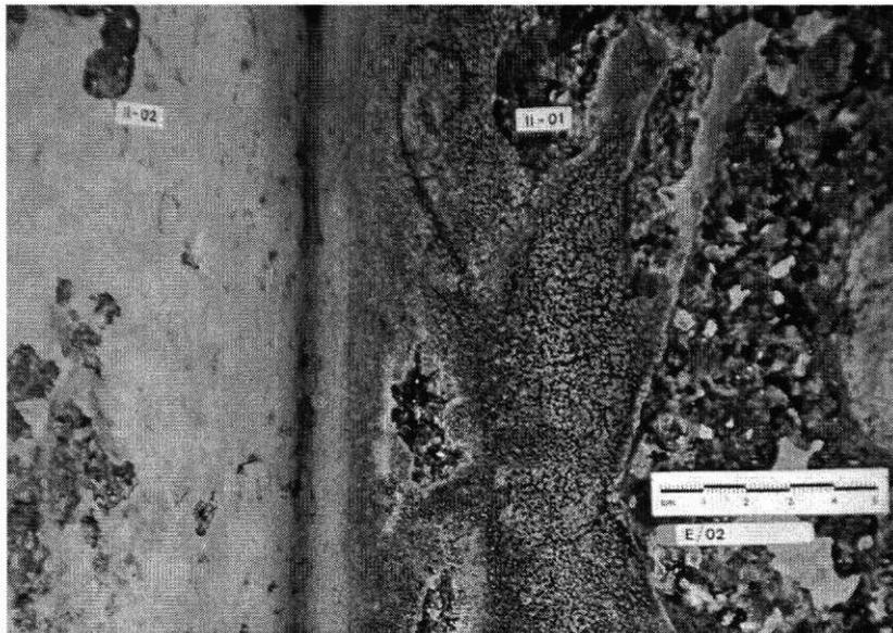
Foto E/02 **Westseite, ca. 50 cm vom Boden**; zwei Arten der weißen Ablagerung, rechts „feinkörnig“, leicht grau, relativ dick (ca. 1-1,5 mm), links kompakt, glatt, leicht bräunlich, beide Seiten sind teilweise (Läuferspuren) dunkelgrau (Wasserabfluß); die Kanten bei der Falkendarstellung sind leicht verwittert, einige frische Ausbrüche.
