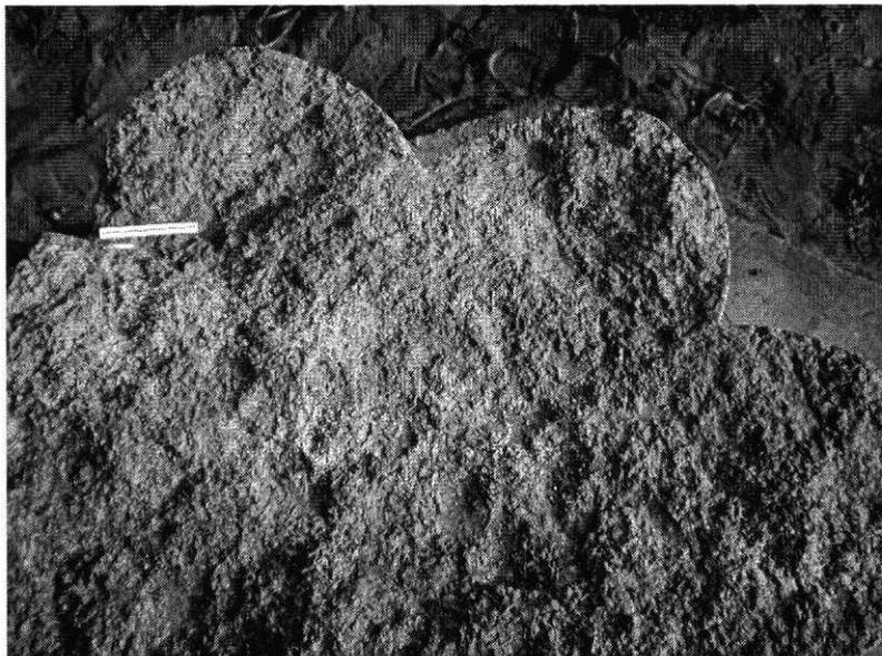
Foto G/11 **Nordostseite, ca. 10 cm von unten**; abgebrochene Ecke von einem Bündelement, darunter Schalenbildung parallel zur Bruchfläche; Schalen überlappen sich teilweise (2-3 Niveaus; 0,3-2 cm dick), kleine Stellen mit Schuppenbild (0,5-1 cm<sup>2</sup> groß), keine mechanische Beanspruchung von unten (Holzbalken unter dem Element neben links).
