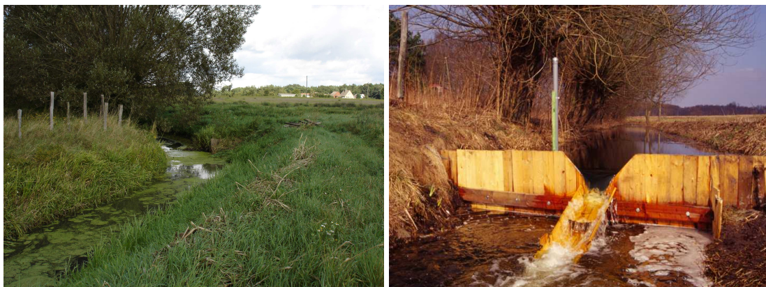
Abbildung 4.5: Mühlengraben ca. 250 m vor Zufluss in den Großen Graben, Aufnahme im Sommer ungestaut (links) - mit Überfallwehr im Winter (rechts)
