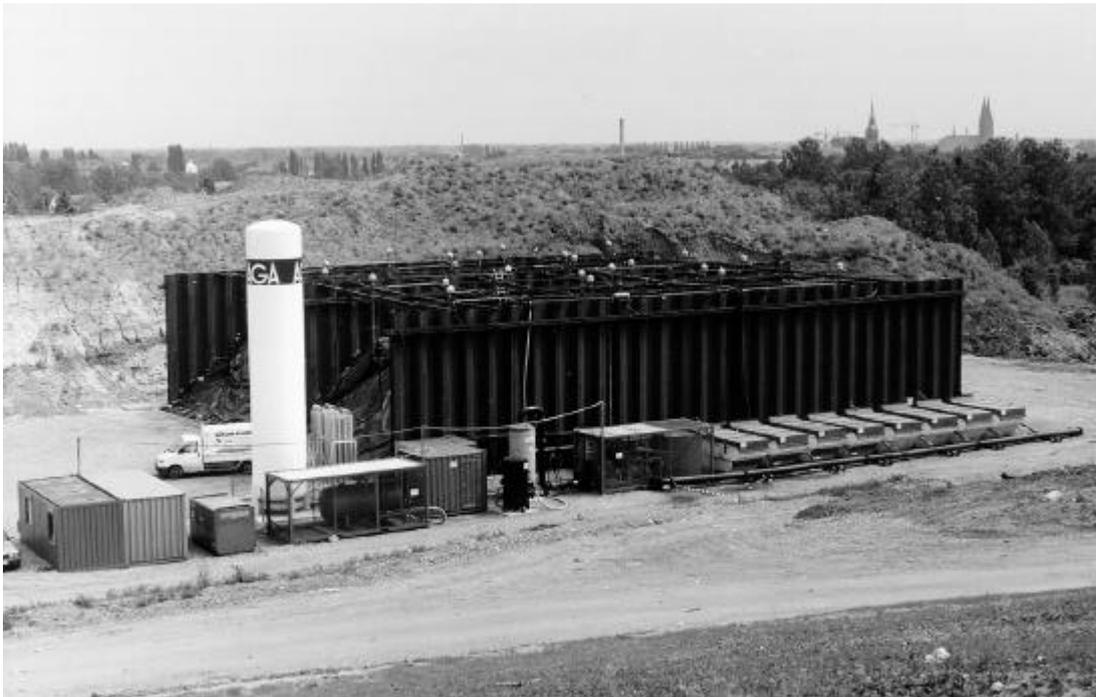
**Abb. 2** Eingehauste, gekapselte Biologische Stabilisierung mit vollständiger Gasbehandlung zur nachfolgenden Stofftrennung, hier: Testausführung ohne Dach und Tore
