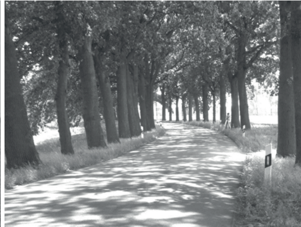
Abb. 3-2: Nivellement-Vermessung der Straße zwischen Vehlgast und Klein-Damerow im Polder Vehlgast
