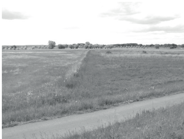
Abb. 3-36: Neuzeller Niederung mit Durchbruchgraben (verschilft) am Oder-km 543,2
