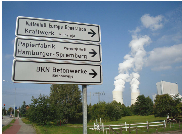
Kraftwerk Schwarze Pumpe/Milinarnja Carna Plumpa
