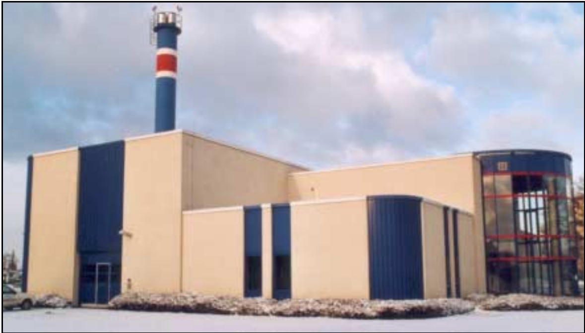
Abbildung 12: Hydrothermales Kraftwerk Neustadt-Glewe, Hauptgebäude (eigene Aufnahme)
