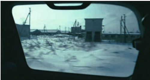
Abb. 16: Verfallene Industrieanlagen. JA TOŽE CHOČU
