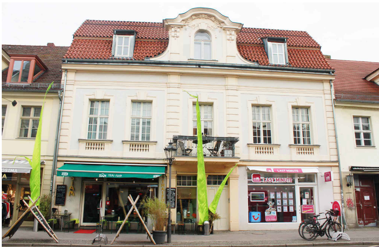
Das ehemalige Neumannsche Wohnhaus in der Friedrich-Ebert-Straße 13.
