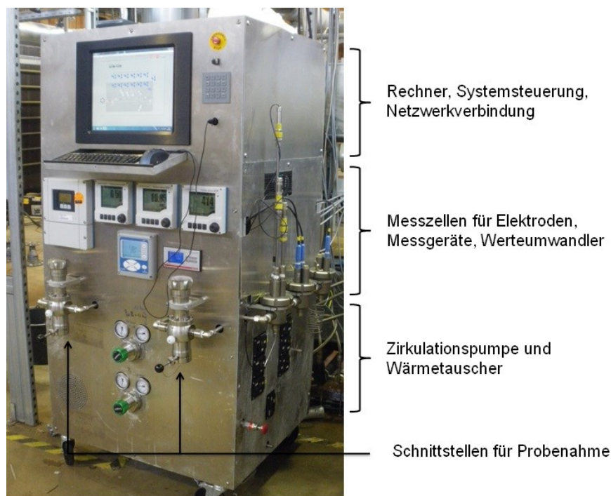
Bild 3.3 - 1. Fluid-Geochemisches Monitoringssystem (FluMo), installiert am Standort Groß Schönebeck.
