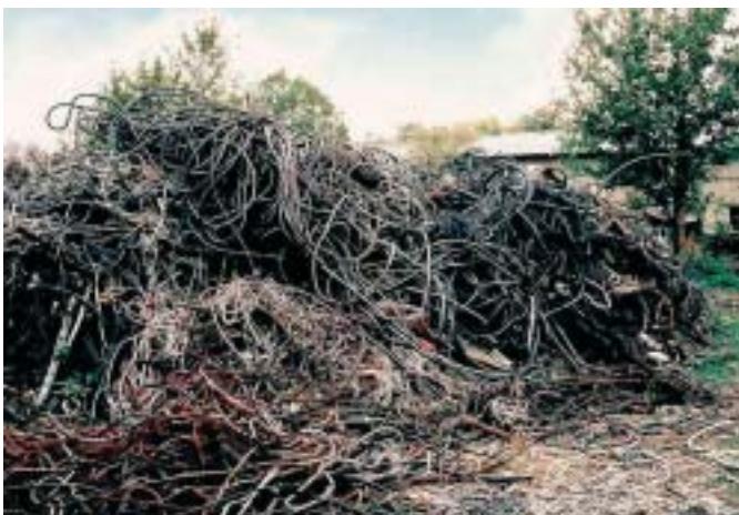
Beim Rückbau von Tagebauen entstandene Haufwerke von Kabelmischgranulaten und Schälkabelummantelungen
