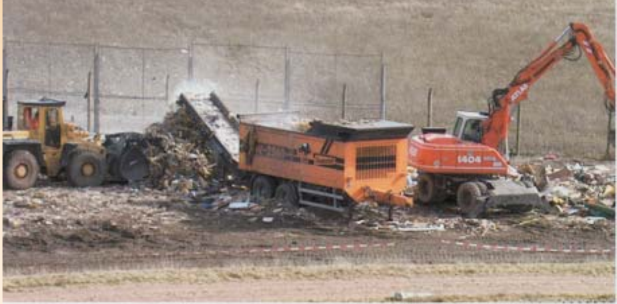
Deponie im Landkreis Potsdam-Mittelmark: Erhöhung der Einbaudichte durch Einsatz eines Schredders
