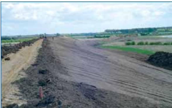
**Baulos 1 - Profilierung des Mutterbodens auf der ws Böschung**
