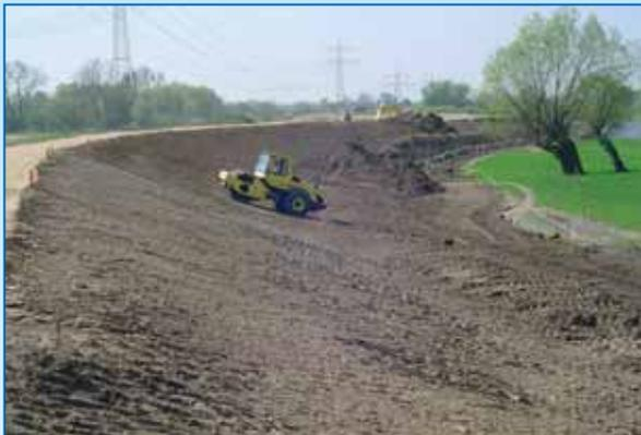
Verdichtung der wasserseitigen Lehmdichtung
