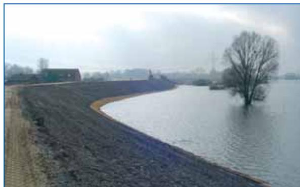
Sicherung der wasserseitigen Böschung mittels Kokosmatten im Winter 2007 aufgrund erhöhter Elbe-Wasserstände
