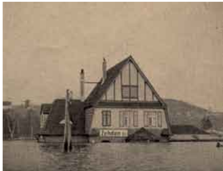
Deichbruch und Überflutung des Zehdener Polders (Foto: Rehdorf 1940)
