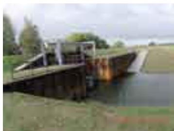
2 Fertiggestelltes Einlaufbauwerk Güterbieser alt Oder, wasserseitige Ansicht (Fotos: M. Oelze)
