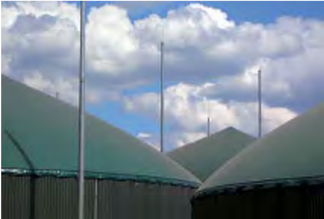
Biogasanlage Nennhausen, Landkreis Havelland mit aufwändigem Blitzschutz (Foto: H.-J. Gareis)
