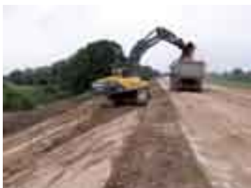
1 Abtrag der Landseitigen Böschung im Baulos 55 (Fotos: U. Blüher)
