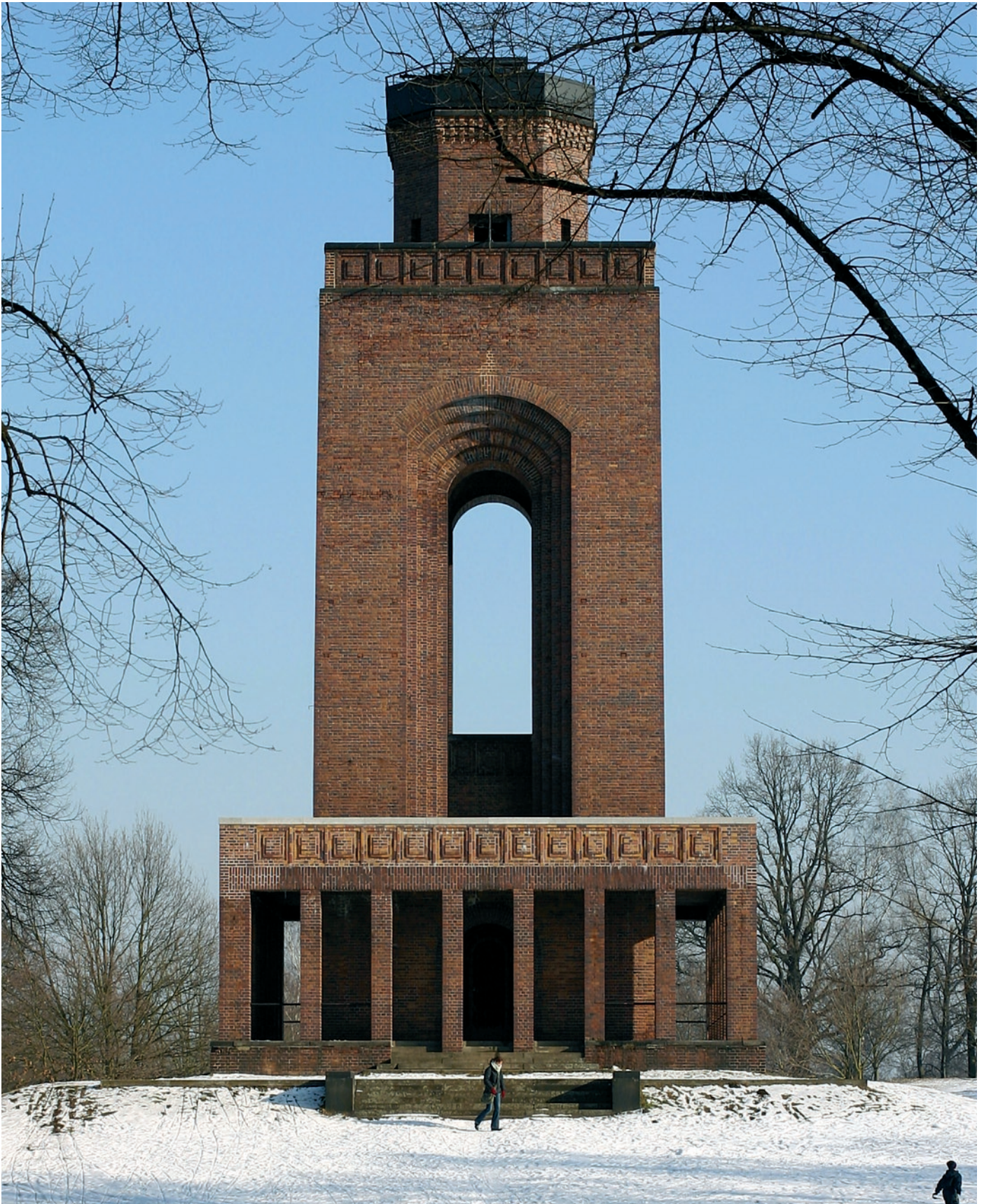
Burg/Spreewald (Borkowy/Blota; SPN), Bismarckturm, 1913–15 nach Entwurf von Bruno Möhring auf dem als Bodendenkmal geschützten Schlossberg errichtet. Ziegelsichtiger Aussichtsturm mit Feuerschale und zugleich Denkmal für die Gefallenen des Ersten Weltkrieges.
