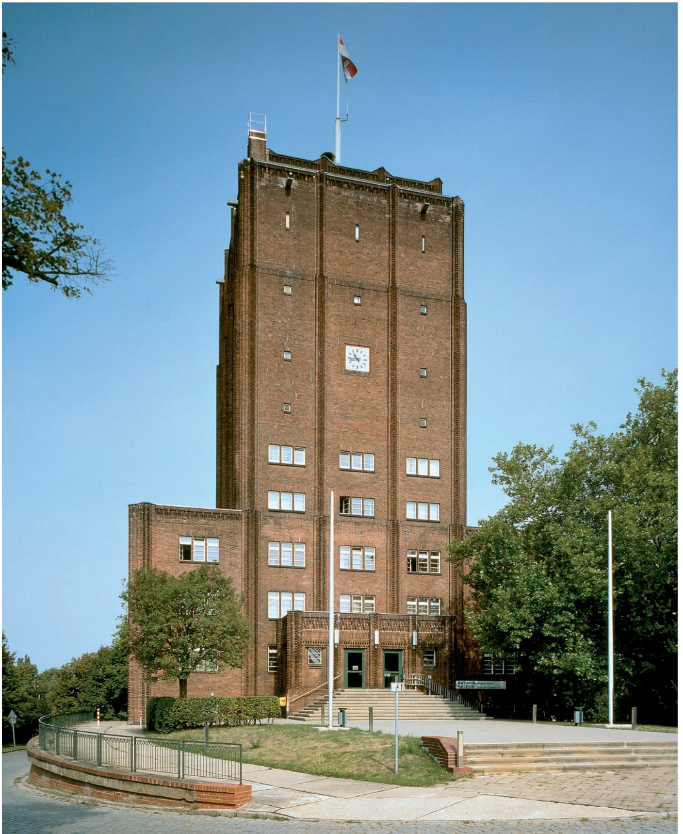
Neuenhagen (MOL), Rathaus. Das Rathaus mit Wasserturm wurde 1926 nach einem Entwurf von Wilhelm Wagner als Eisenbetonkonstruktion mit Klinkerfassade ausgeführt.
