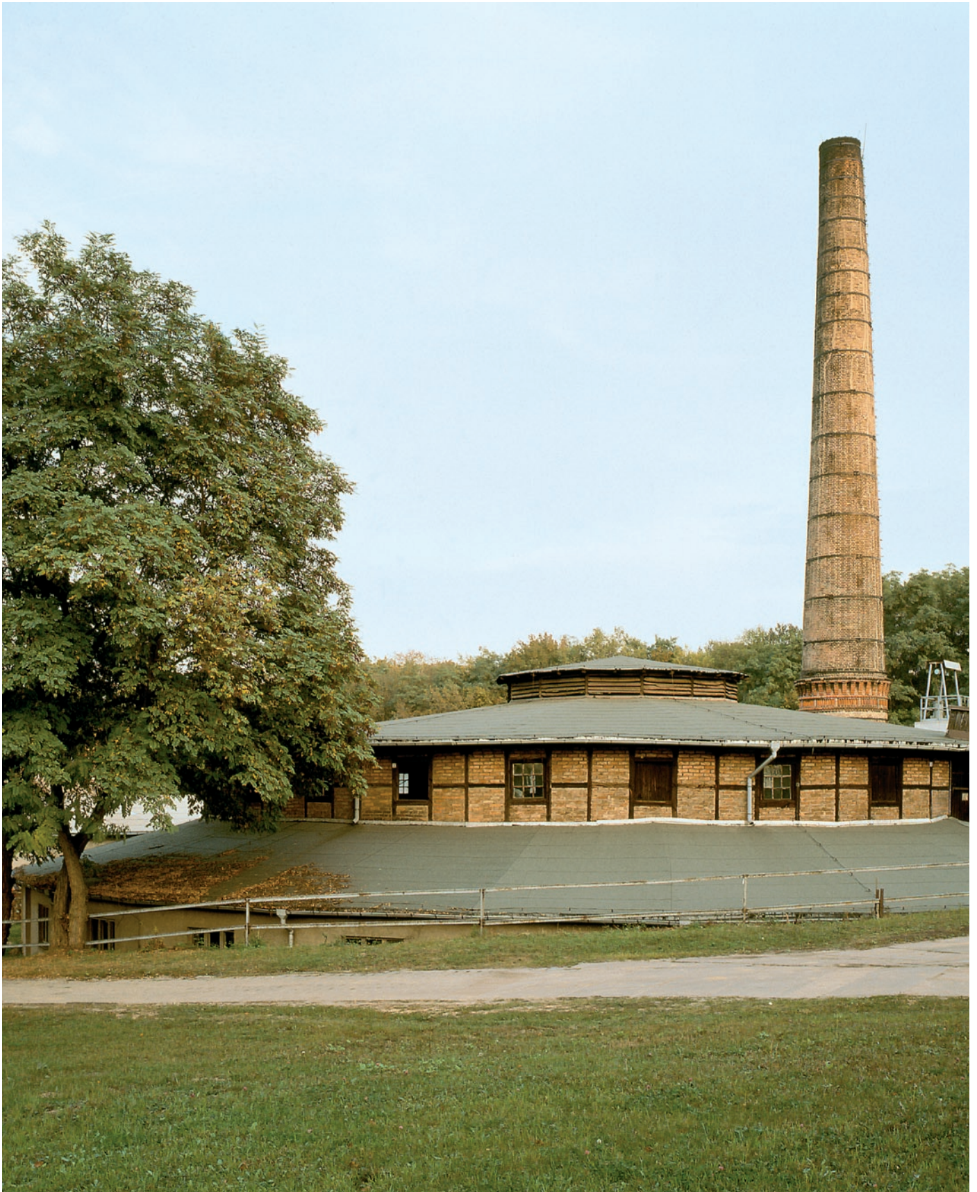
Glindow (PM), Ziegelei, 1868. Einer der letzten in der Region erhaltenen Ziegelöfen, die einst mit ihren hohen Schloten die Landschaft um den Glindower See prägten. Bis vor wenigen Jahren war der Ringofen noch in Betrieb. Heute ist auf dem Gelände der Ziegelei ein Museum eingerichtet.
