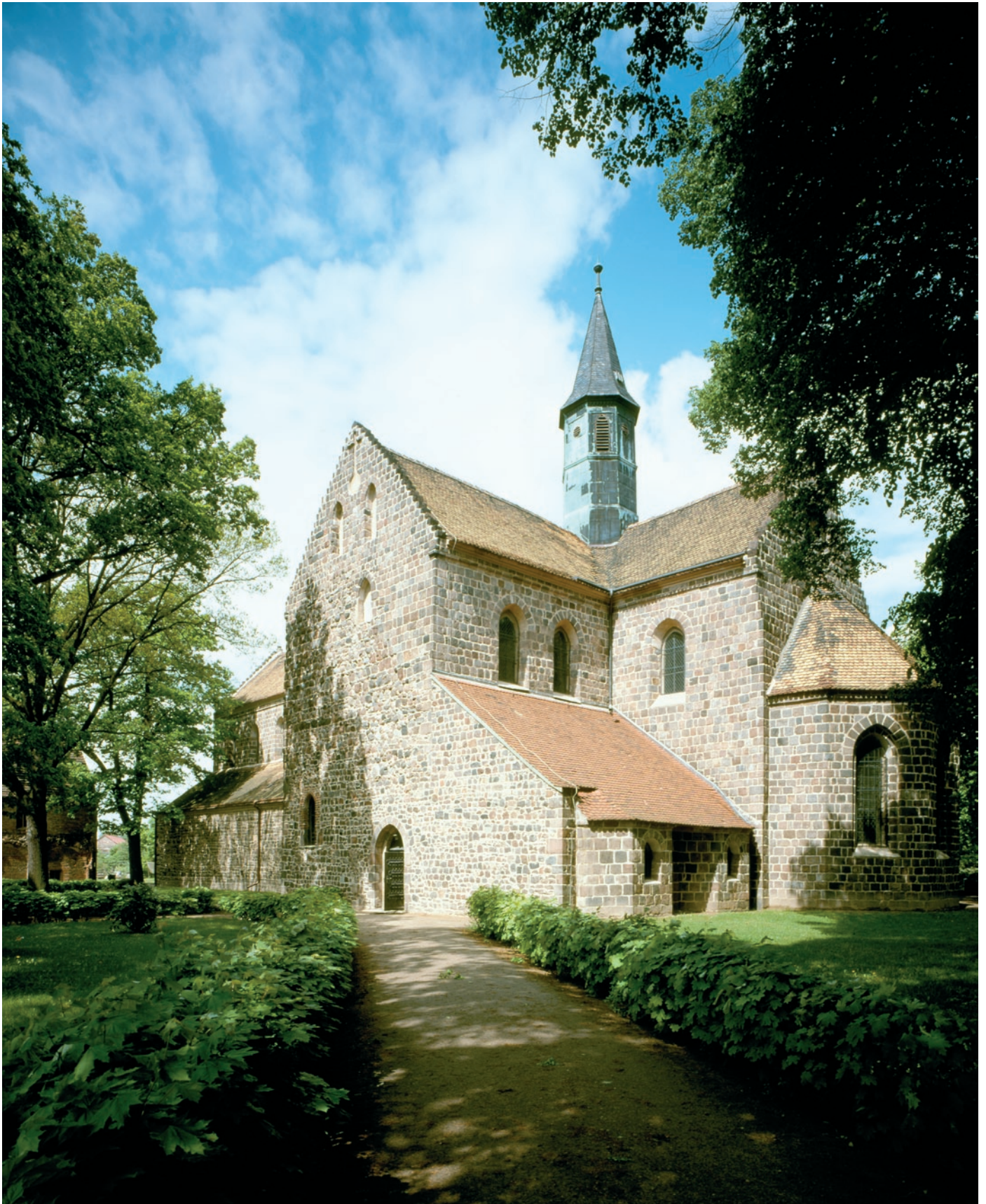
Kloster Zinna (TF), Zisterzienser-Klosterkirche. In seiner würdevollen Schlichtheit verkörpert der spätromanische Bau die Ordensideale Strenge und Bescheidenheit. Statt Backstein fanden die auch bei Dorfkirchen üblichen Feldsteine Verwendung, allerdings in außerordentlich sorgfältiger Bearbeitung.
