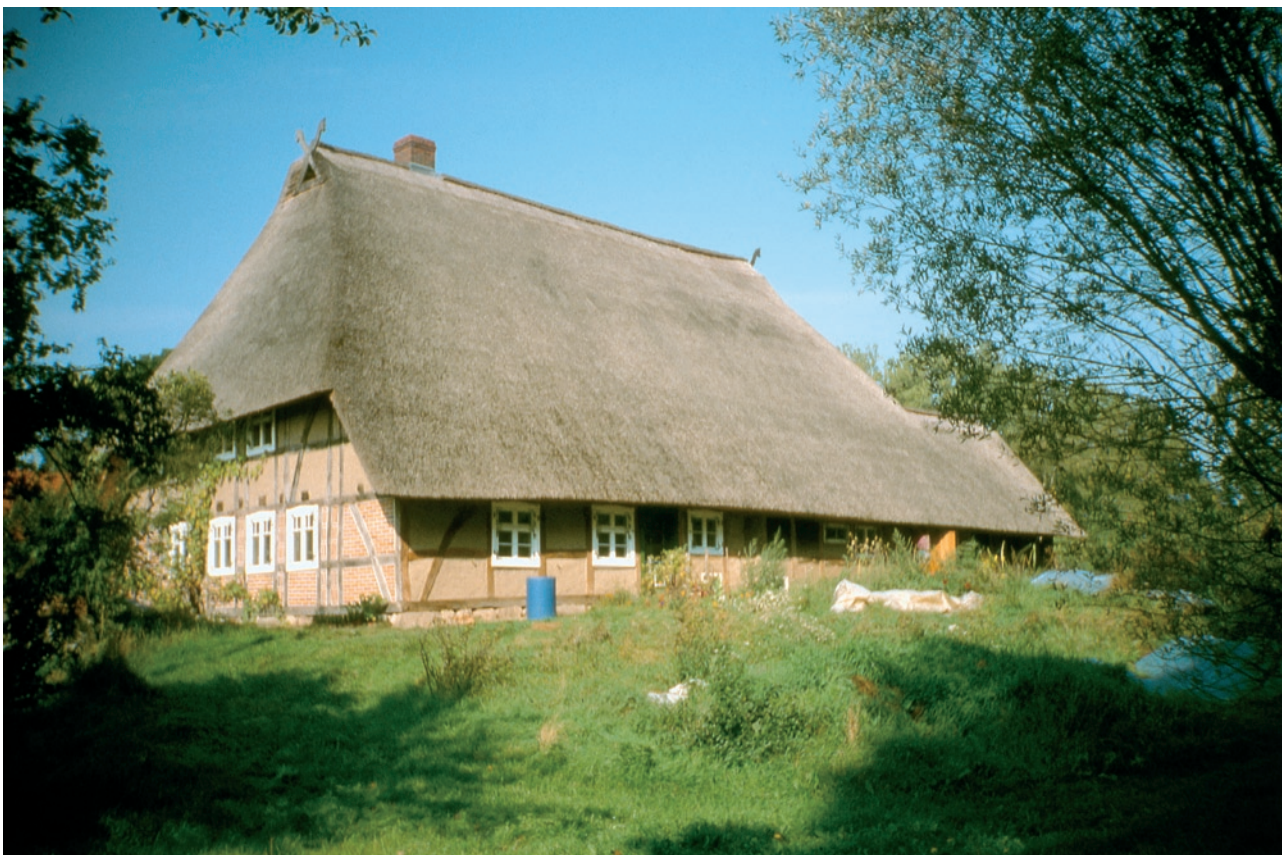
Pillgram (LOS), Biegener Straße 3, Vorlaubenhaus. Dorfkrug und Ausspanne mit mächtigem Strohdach, Mitte 18. Jahrhundert, eine eindrucksvolle ländliche Bauform der Mark. Die Nutzung als Heimatsstube ermöglichte eine Restaurierung 1991–93 unter Beibehaltung vieler ursprünglicher Baudetails.
