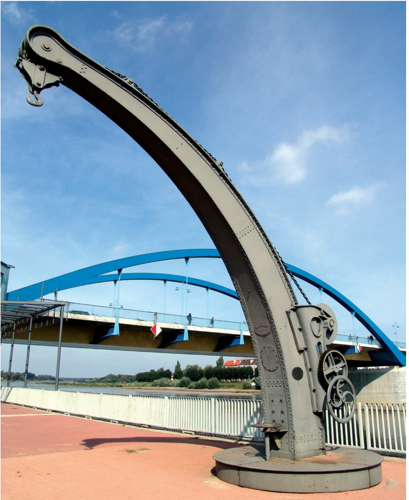
Frankfurt (Oder), Oderpromenade, Hafenkran, um 1860. Südlich der Oderbrücke am Flussufer stehender Drehkran der Maschinenfabrik H. Gruson aus Bockau bei Magdeburg. Als Zeugnis des Oderhandels verweist er auch auf den einstigen städtischen Packhof. 1993/94 restauriert.
