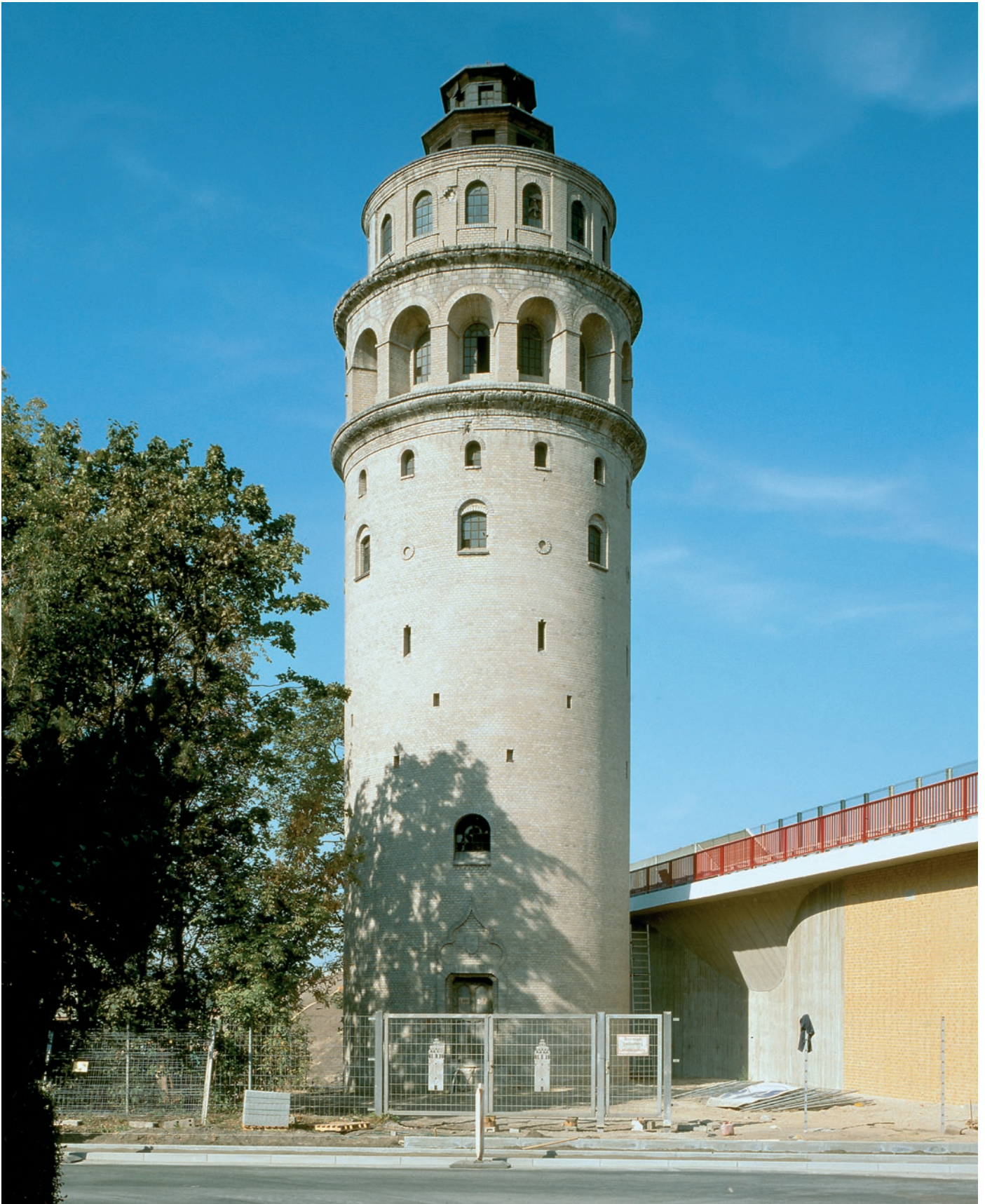
Niederlehme (LDS), Wasserturm, 1908 für die angeschlossene Kolonie der Berliner Kalksandsteinwerke. Der eigenwillige Bau kopiert mit seinem prägnanten Arkadengeschoss den Galata-Turm in Istanbul.
