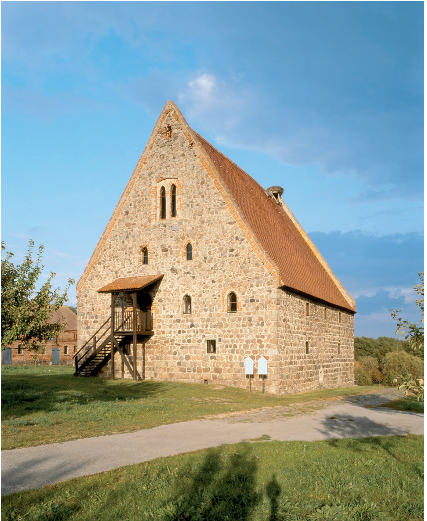
Lietzen (MOL), Speicher der Komturei. Dieser aus dem 14. Jahrhundert überlieferte Feldsteinquaderbau ist das älteste Zeugnis der seit 1229 bestehenden ehemaligen Komturei des Templerordens, die 1318 an den Johanniterorden ging und seit 1814 zum Besitz der Familie von Hardenberg gehört.
