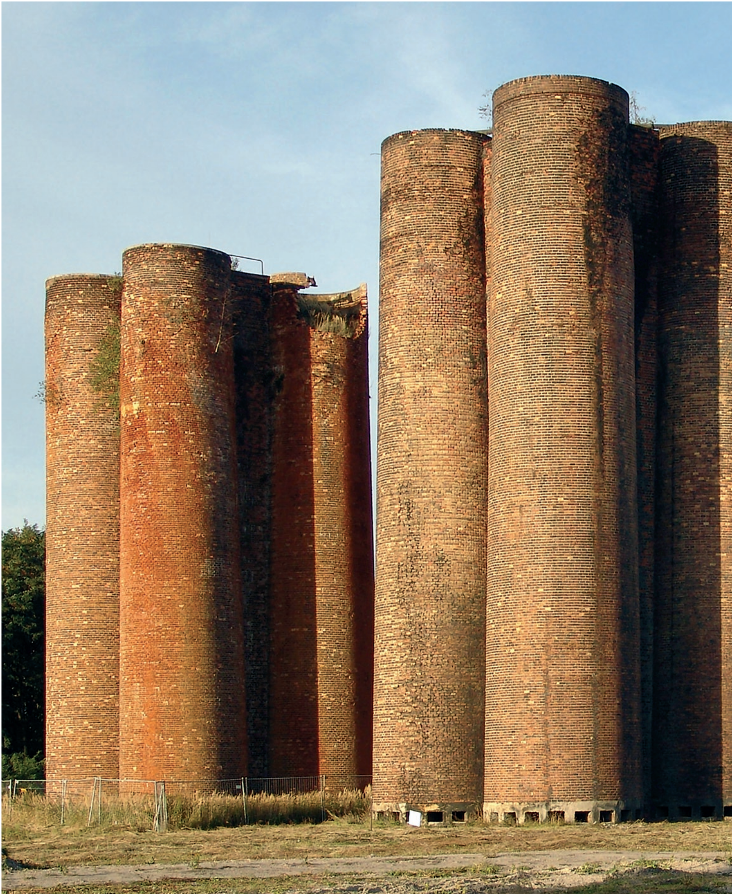
Lauchhammer (OSL), Turmtropfkörper (sogenannte Biotürme), 1956/57 in Betrieb genommene biologische Abwasseranlage zur Aufbereitung der Kokereiabwässer (Beseitigung der Restphenole) der ersten Braunkohlkokerei der Welt. Sie bestehen aus sechs Gruppen von mehr als 22 m hohen Turmtropfkörpern und dem sogenannten Belebtschlammbecken. Eine Turmtopfgruppe wird gegenwärtig zur Begehung für Besucher vorbereitet.
