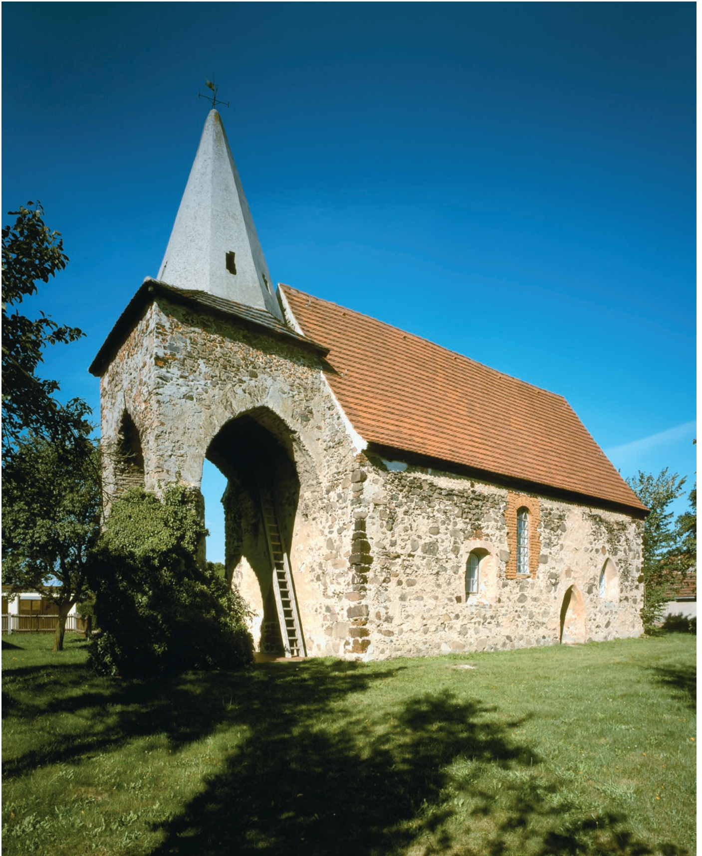
Walddrehna (LDS), Dorfkirche. Der Ende des 13. Jahrhunderts begonnene und vermutlich im 15. und 17. Jahrhundert veränderte Feldsteinbau wirkt durch den Glockenturm in Form einer nach drei Seiten spitzbogig geöffneten Halle als außergewöhnliche Lösung für die Bauaufgabe.
