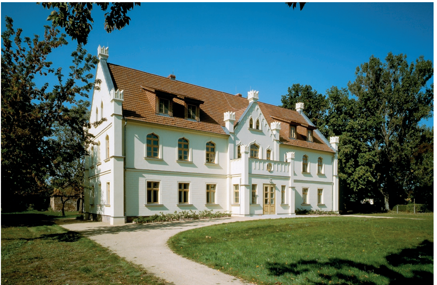
Potsdam, Am Neuen Palais 1, Kaiserbahnhof; 1904–09, Ernst E. v. Ihne. Der »Privatbahnhof« des eisenbahnbegeisterten Kaisers Wilhelm II. in Formen repräsentativer englischer Cottages wurde 1952 stillgelegt. Nach langem Leerstand zunehmend verfallen, erwachte er nach Restaurierung und Umbau als DB-Führungsakademie (2003–05) zu neuem Leben.
