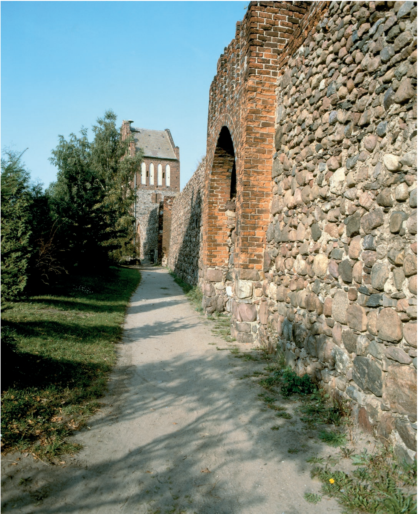
Templin (UM), Stadtbefestigung. Errichtet in der 2. Hälfte des 13. Jahrhunderts aus schichtenweise gefügtem Feldsteinmauerwerk. Die mit Schmuckgiebeln versehenen Tortürme aus Backstein wurden um 1325 erbaut und gelten als frühe Beispiele des in Norddeutschland vorherrschenden Typs.
