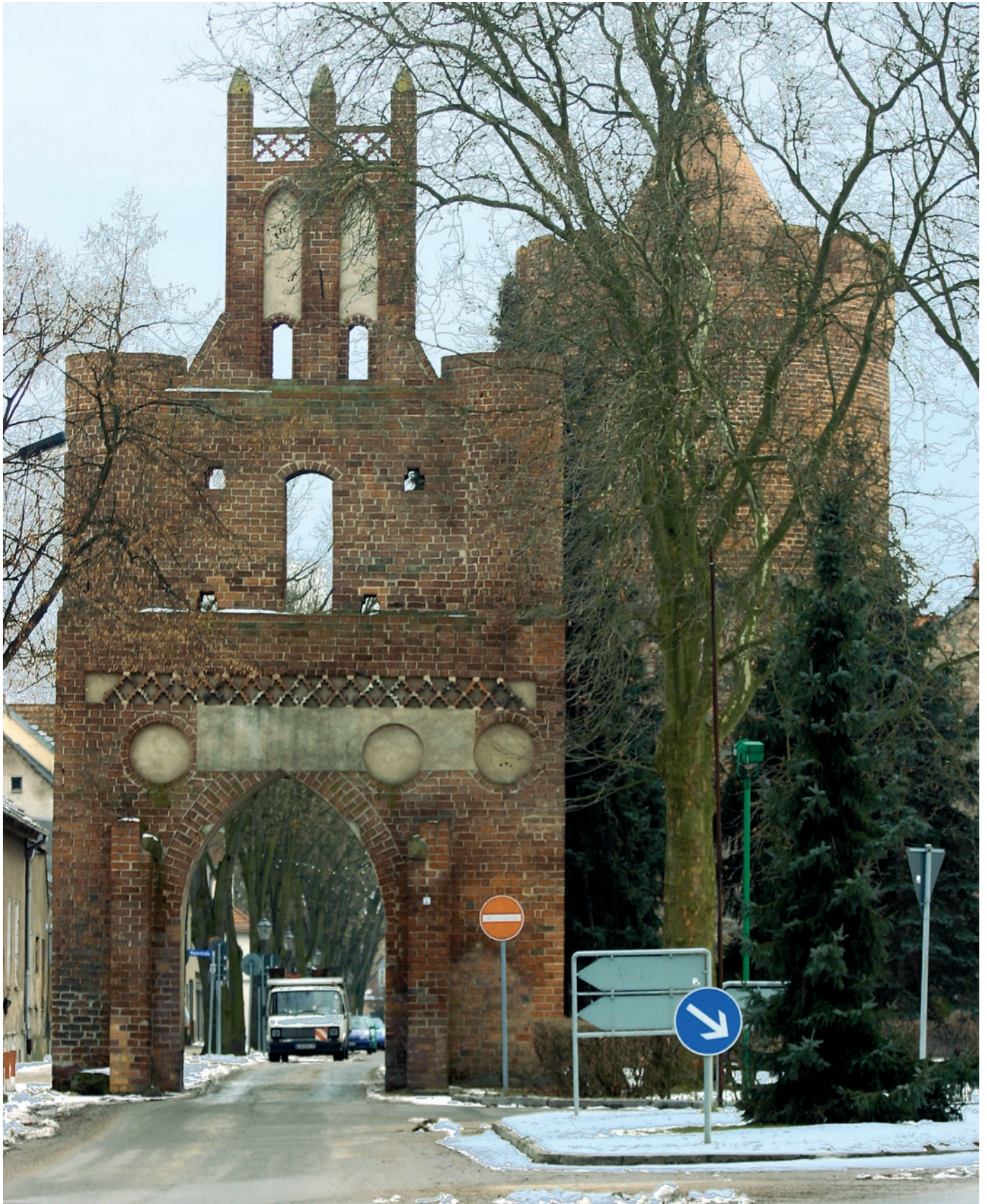
Mittenwalde (LDS), Berliner Tor. Vom spätmittelalterlichen Haupttor ein runder Feldsteinturm erhalten; sein Abschluss mit Zinnenkranz und Kegeldach von 1898. Das Vortor vom Ende des 15. Jahrhunderts mit schönem Ziergiebel flankiert von zwei Rundtürmen. Die Anlage gehört zu den letzten mittelalterlichen Profandenkmalen in der Region.
