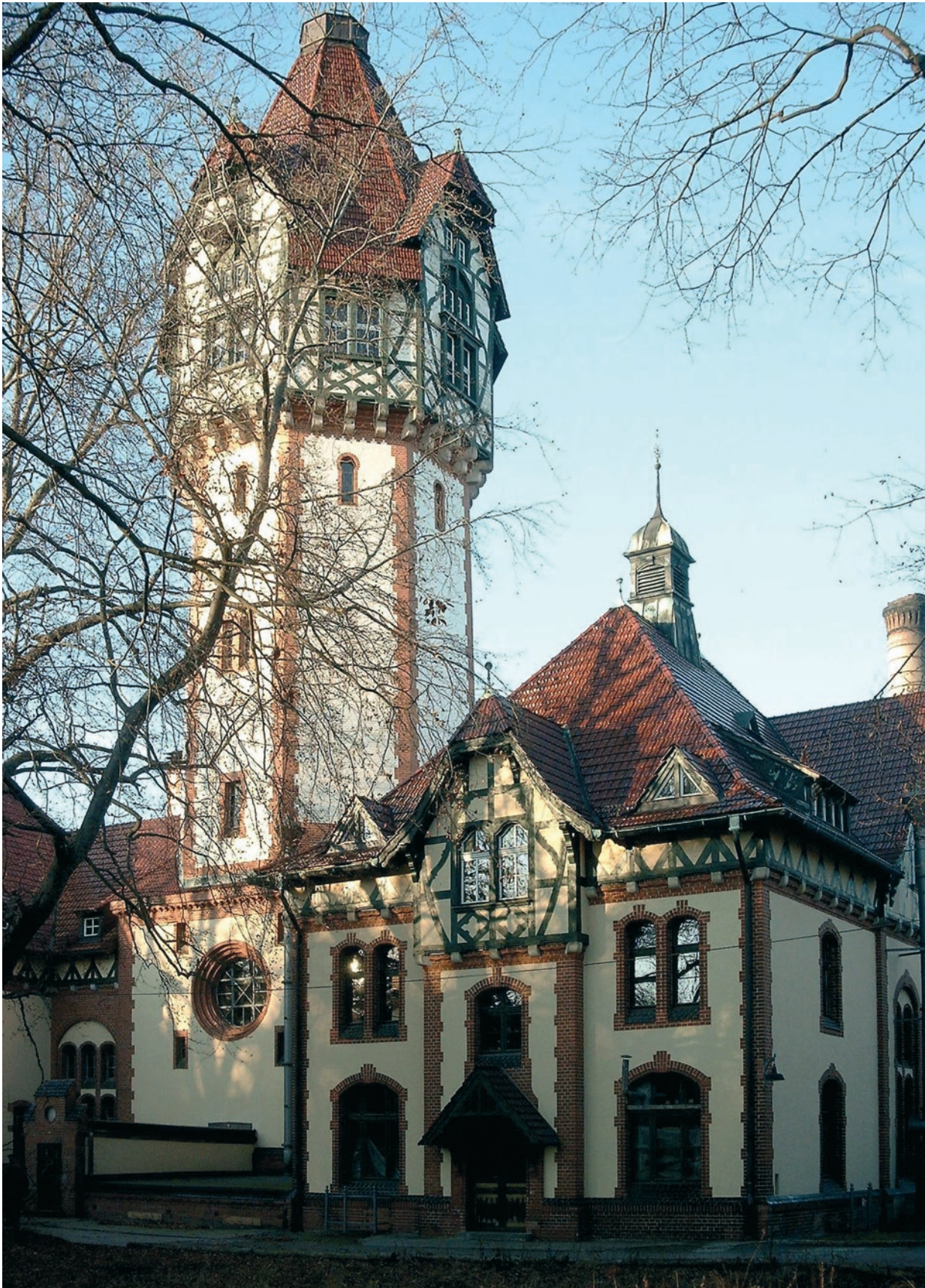
Beelitz Heilstätten (PM), Heizkraftwerk. Blockheizkraftwerk der zwischen 1898 und 1930 von der Landesversicherungsanstalt Berlin errichteten Arbeiter-Lungenheilstätten Beelitz Heilstätten. Es wurde bereits ab 1902 als Kraft-Wärme-Kopplungs-Anlage betrieben und produzierte neben Dampf und Warmwasser für die medizinischen Einrichtungen auch elektrischen Strom.
