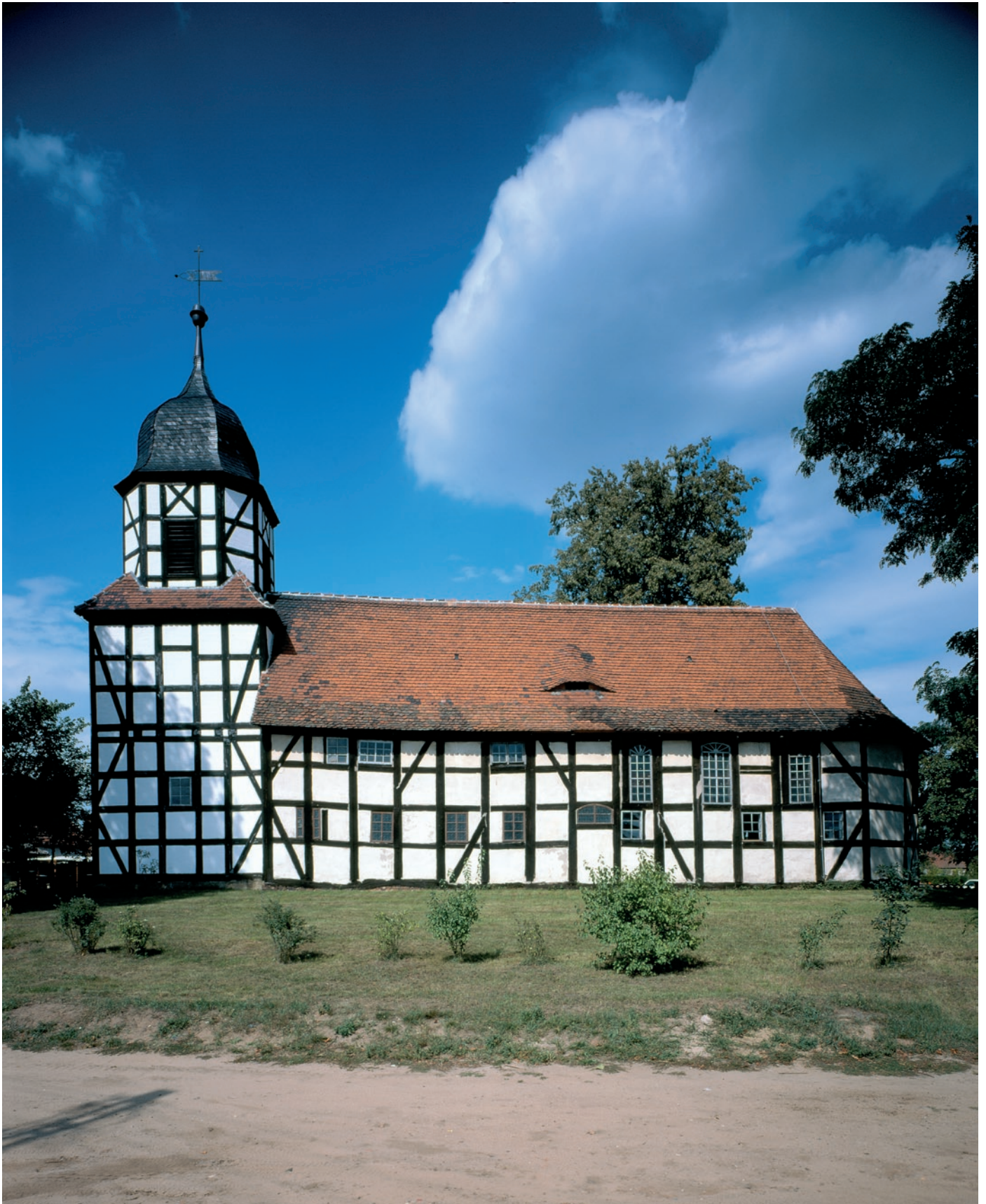
Arnsnesta (EE), Dorfkirche. Der Mitte des 17. Jahrhunderts errichtete, vergleichsweise große Bau gehört zu den ältesten Fachwerkkirchen des Landes. Der auffällige Turm 1748 neu aufgeführt. Der Innenraum mit bauzeitlicher Hufeisenempore 1914/15 einheitlich in hellen Farben gefasst.
