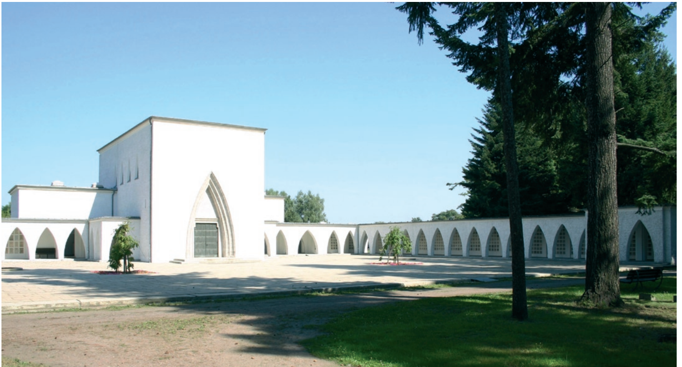
Potsdam, August-Bebel-Straße 26–53, Tonkreuz, 1929, Otto Kohtz. Das schlichte, aber markante verklüftete Gebäude über kreuzförmigem Grundriss war mit vier schall- und schwingungs isolierten Tonfilmateliers – den ersten in Deutschland – der modernste Bau der Ufa-Studios in Babelsberg. Kohtz avancierte mit ihm zum prägenden Architekten der in den 1930er Jahren geplanten »Filmstadt«.
