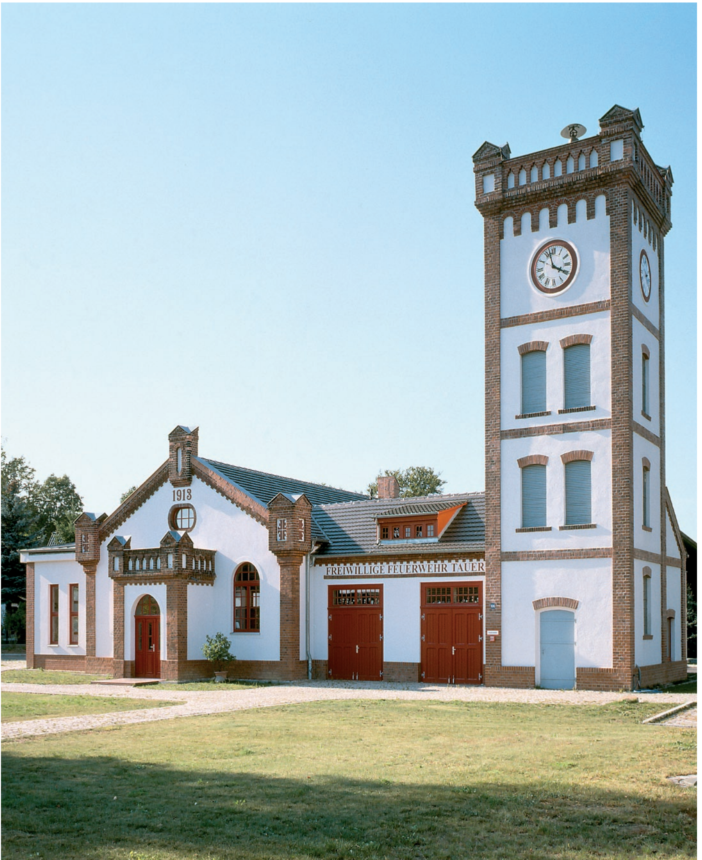
Tauer (Turje; SPN), Feuerwehrgerätehaus, 1896 neben dem Gutshaus im Ortskern gebaut. Dem Turm wurde 1913 eine Turnhalle angefügt. Im Zuge der jüngst vorgenommenen Renovierung behutsamer Umbau zum Einstellen moderner Löschfahrzeuge.
