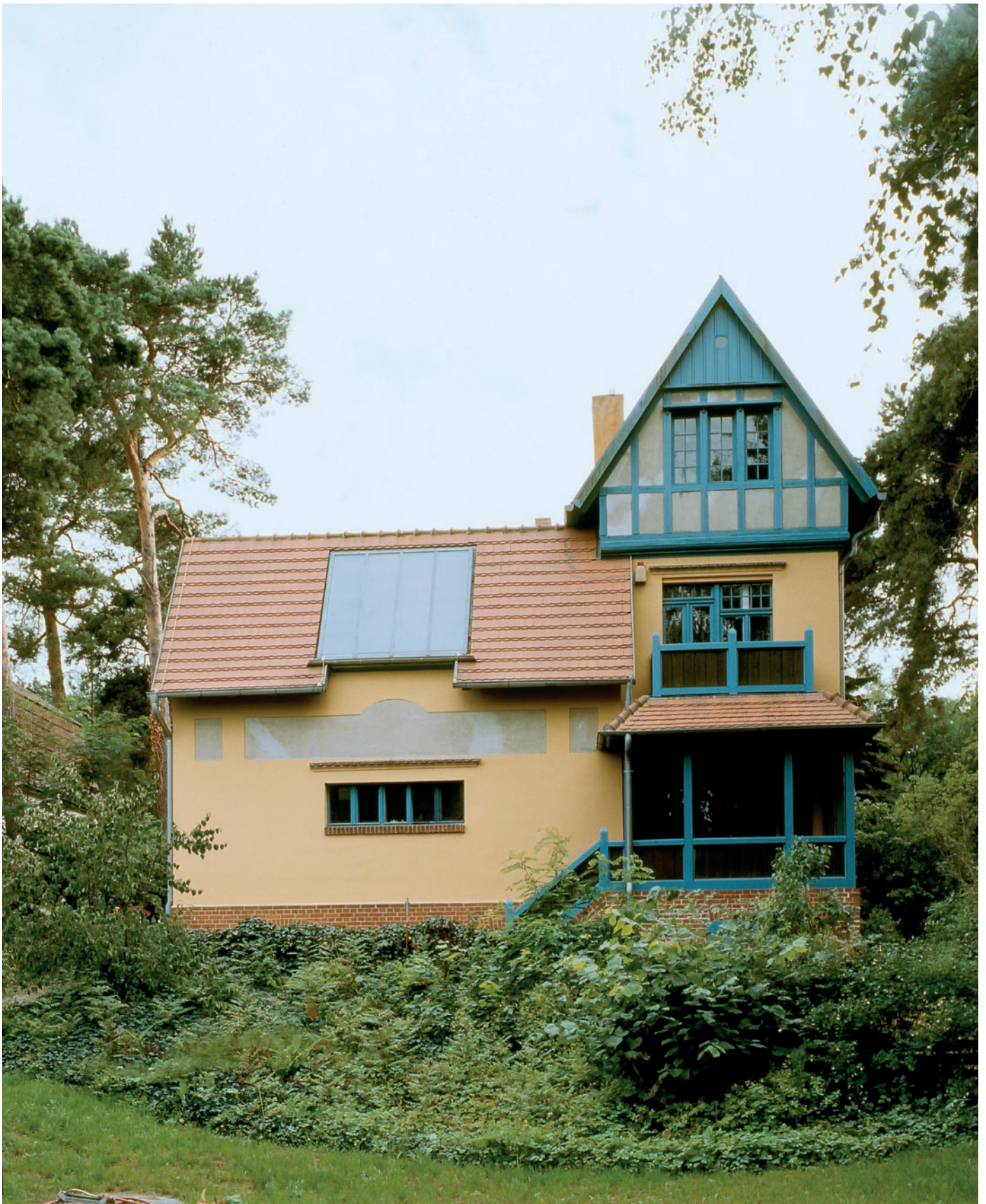
Woltersdorf (LOS), Köpenicker Straße 46, Fidus-Haus. Das Atelier, Wohn- und Gästehaus entstand 1907–09 nach Entwürfen des Jugendstilmalers Fidus. Hier verwirklichte er seine Vorstellungen von naturnahem Leben und Arbeiten. Zugleich bildete das Haus einen wichtigen Treffpunkt gleichgesinnter Lebensreformer.
