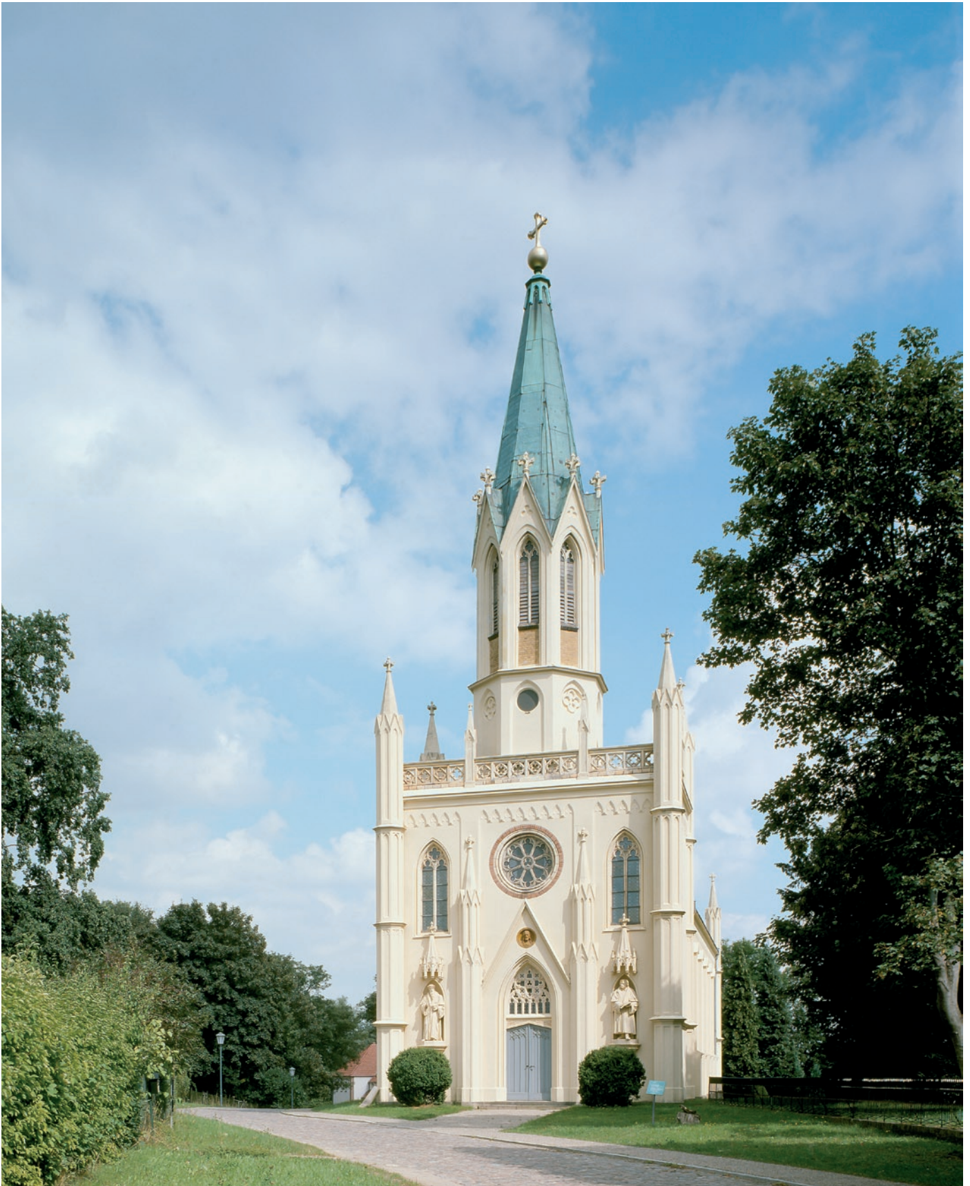
Wolfshagen (UM), Kirche. 1858 im Zuge der Verschönerung des Wolfshagener Gutes unter Graf Hermann von Schwerin als Saalbau in neugotischen Formen fertiggestellt. Die Westfront ist als repräsentative Schaufassade wirkungsvoll in die Flucht der Dorfstraße platziert.
