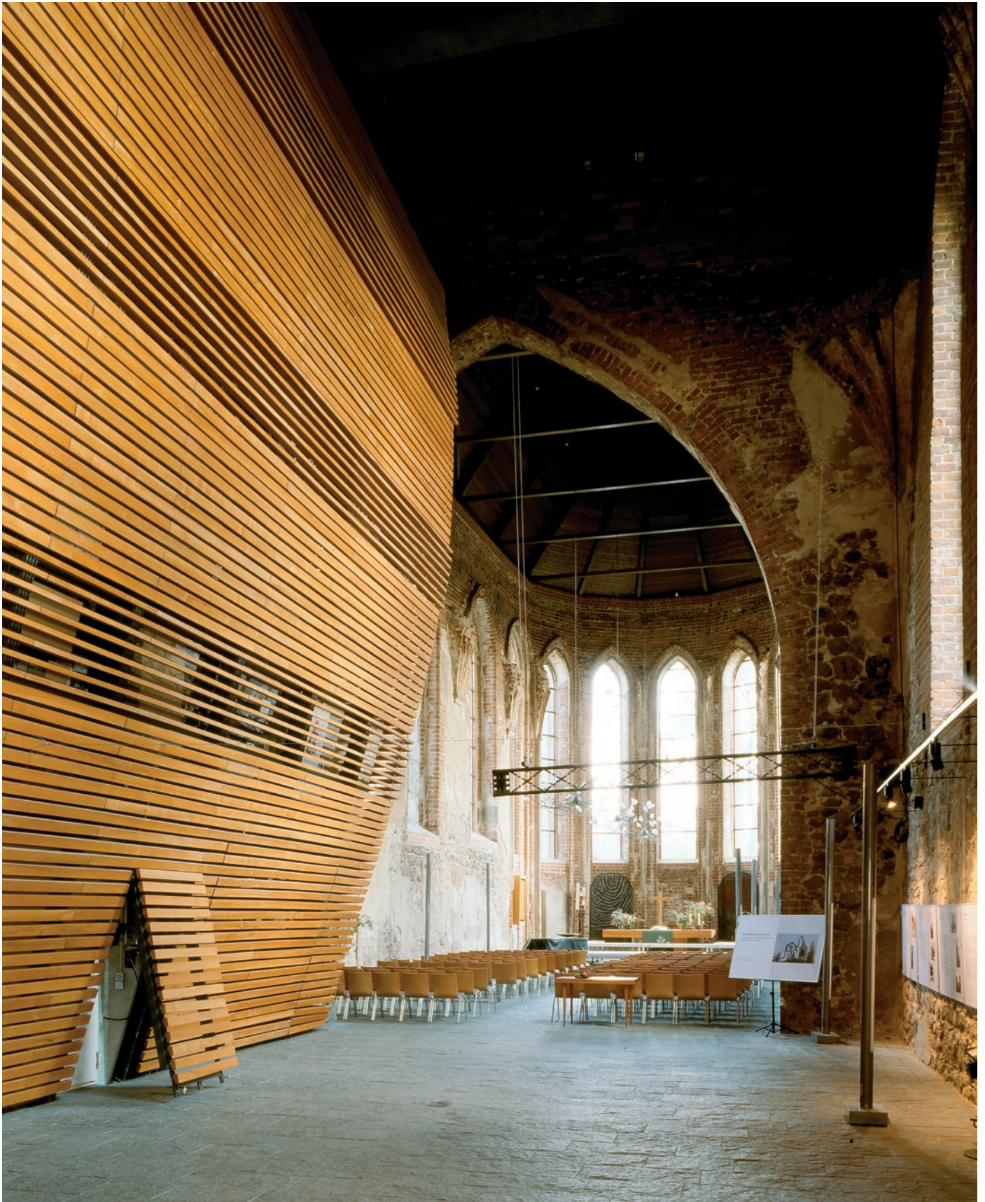
Müncheberg (MOL), Stadtkirche St. Marien. Die durch Kriegsschäden 1945 ruinöse zweischiffige Backsteinhalle mit 1827 von Karl F. Schinkel ergänztem Turm erhielt 1996 ihr hohes Satteldach zurück und im Inneren den viergeschossigen Einbau der Stadtbibliothek mit Gemeindezentrum von Klaus Block.
