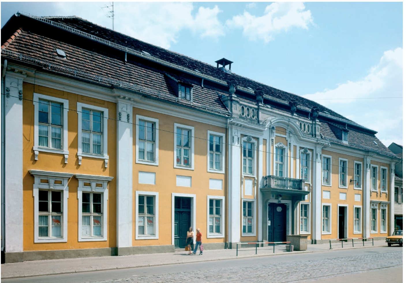
Neuhausen (PR), Schloss, 1373 markgräflische Feste genannt, 1738 für Gebhardt von Winterfeldt unter Einbeziehung mittelalterlicher Bausubstanz neu gebaut. In der Kapelle eine Renaissance-Ausmalung des 16. Jahrhunderts.
