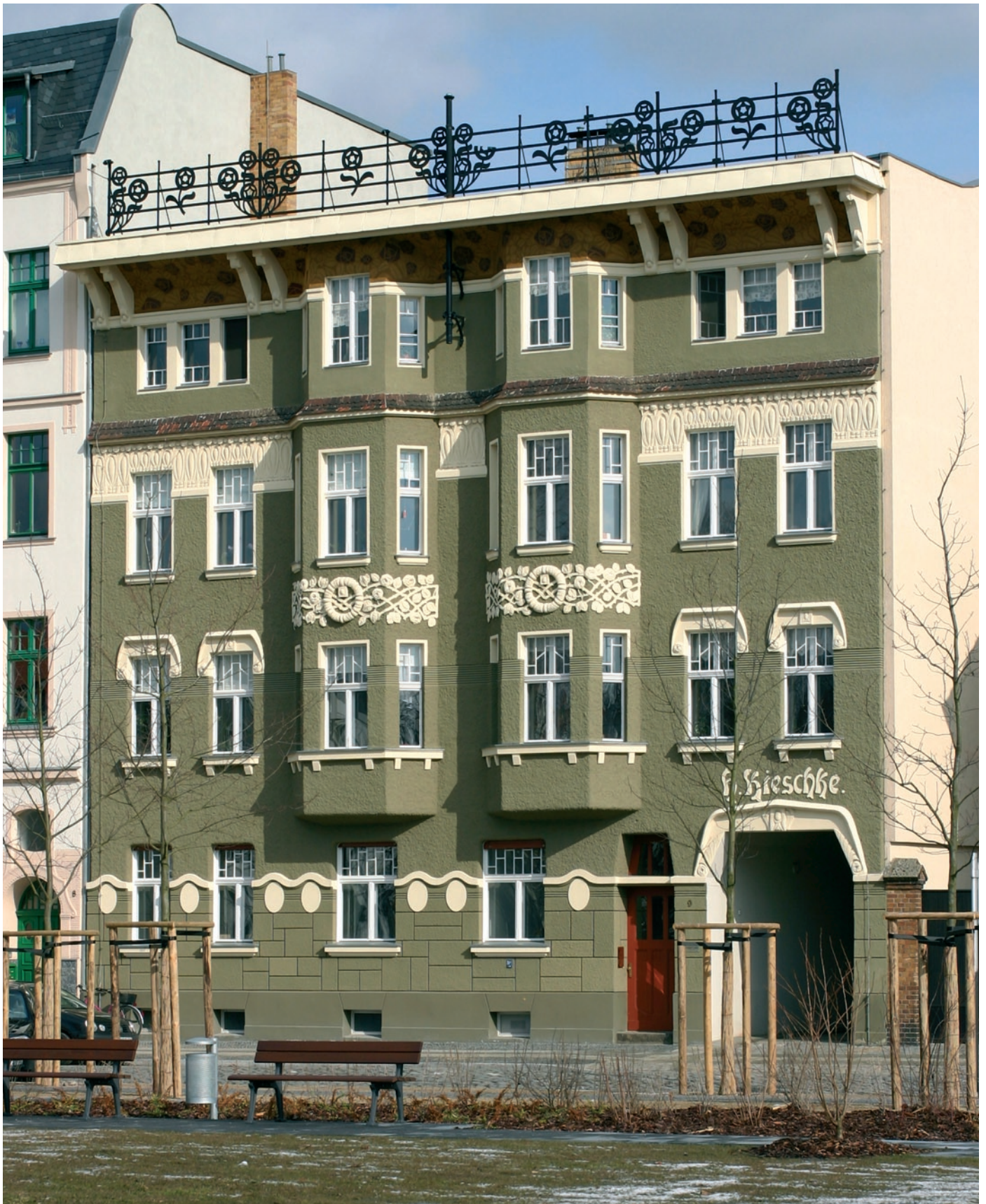
Cottbus (Chósebus), Wernerstraße 9, Mietwohnhaus, 1905/06 nach Entwurf des Cottbuser Architektur- und Baugeschäfts Dümpert & Hauke im Auftrag des Schmiedemeisters Hermann Kieschke. Mit seiner überaus individuellen, qualitativollen Fassadengestaltung in Formen des Jugendstils zählt es zu den schönsten Wohnhäusern in Cottbus.
