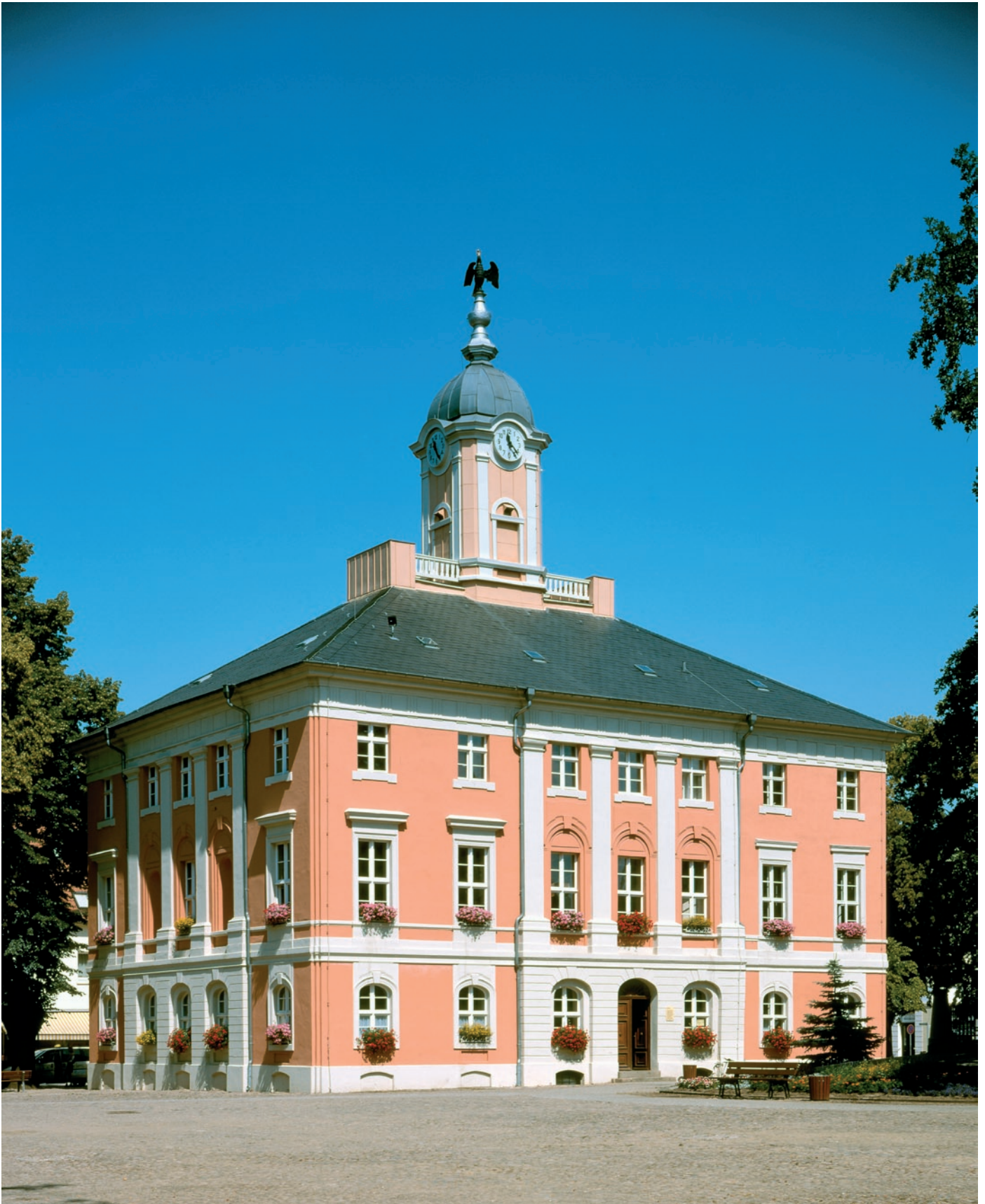
Templin (UM), Rathaus. 1746–51 nach Plänen von Karl S. Schmidt und Johann G. Kemmeter auf dem Marktplatz errichtet. Zwei kriegszerstörte Achsen wurden 1963–65 wiederhergestellt. 1991–98 erfolgte die letzte durchgreifende Instandsetzung.
