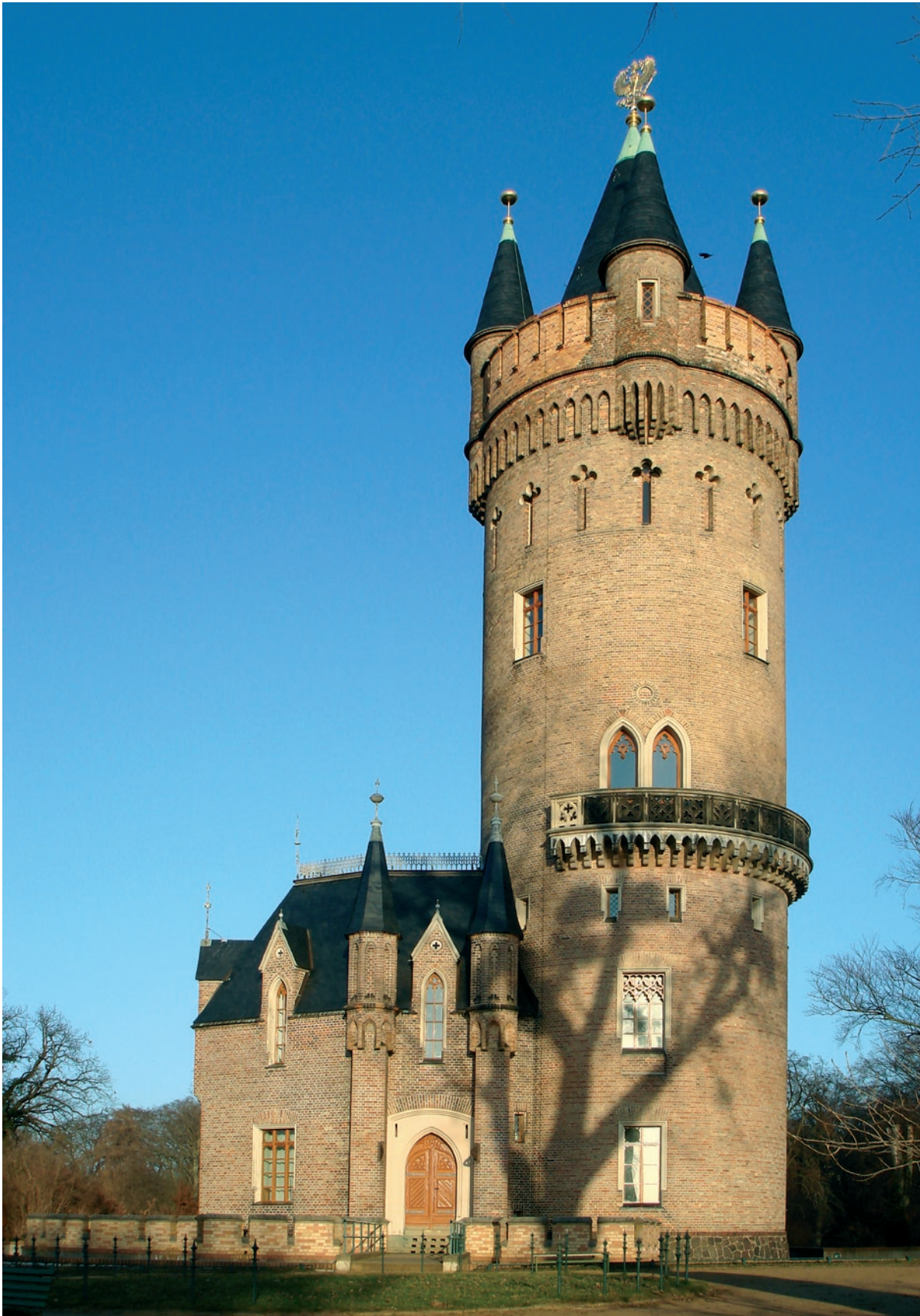
Potsdam, Flatowturm im Park Babelsberg, 1853–56 von J. H. Strack. Wuchtiger Rundturm mit seitlichem polygonal gebrochene- nem Anbau, bestimmt zum zeitweiligen Aufenthalt von Wilhelm I. Mit vorkragendem Wehgang, Erkertürmchen und Spitz- helm dem spätgotischen Eschenheimer Tor in Frankfurt am Main nachgebildet. 1945 beschädigt, Wiederherstellung 1986–93.
