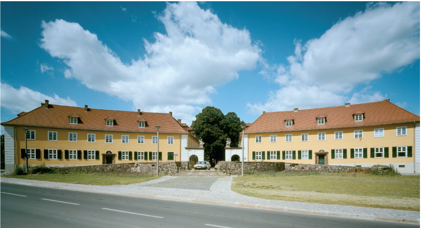
Luckenwalde (TF), Industriestraße 1, Hutfabrik Steinberg, Herrmann & Co., 1922/23, Erich Mendelsohn. Die große, als Eisenbeton-Rahmenkonstruktion ausgeführte Halle, einst von einem charakteristischen »Hut« bekrönt, ist eine Inkunabel der modernen Industriearchitektur.
