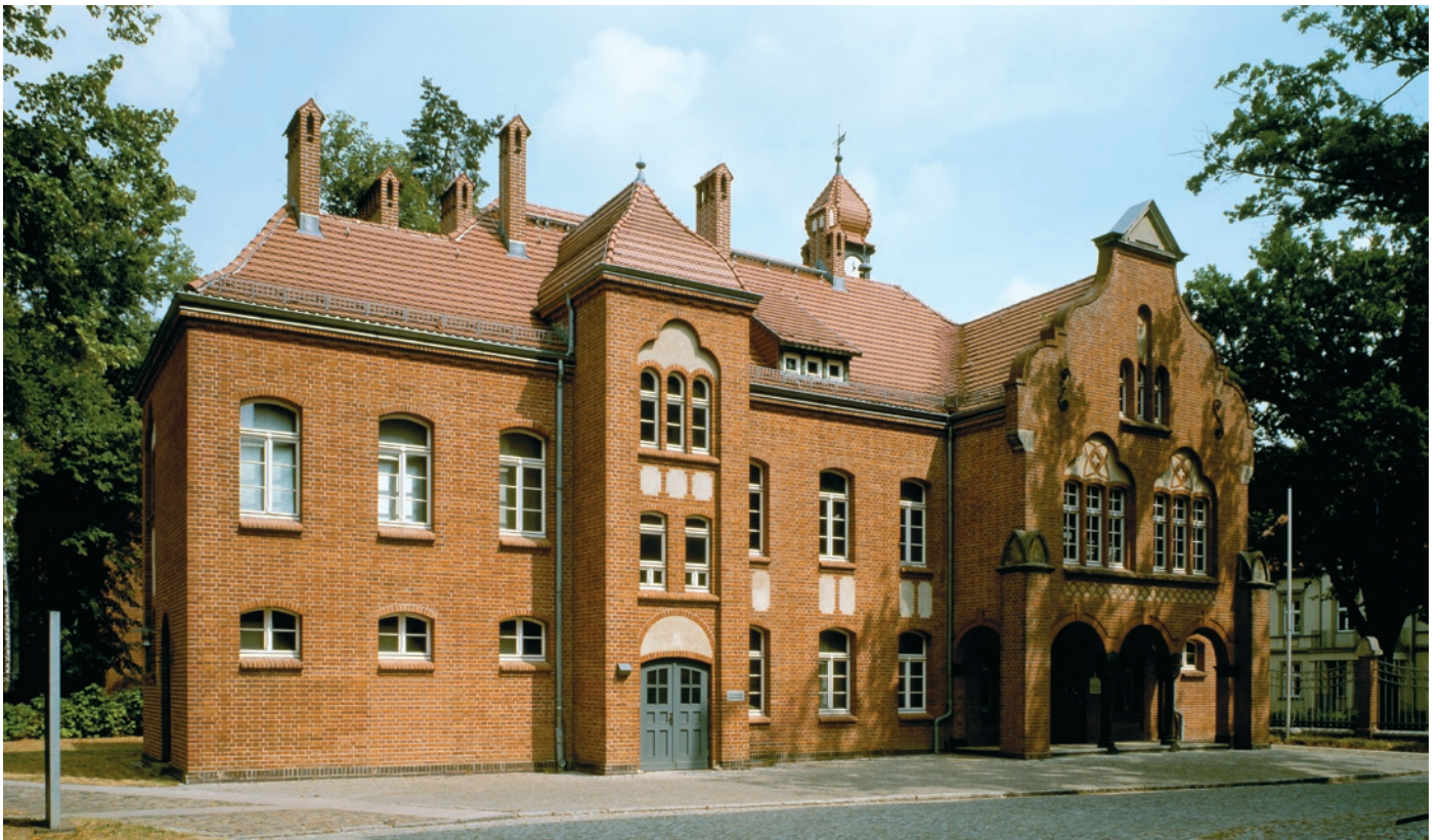
Neuruppin (OPR), Fehrbelliner Straße 137, ehemaliger Paulinenauer Bahnhof, 1899–1901. Der verkehrs- und stadtgeschichtlich wichtige Bahnhof wird seit seiner Sanierung als Büro- und Geschäftshaus genutzt.
