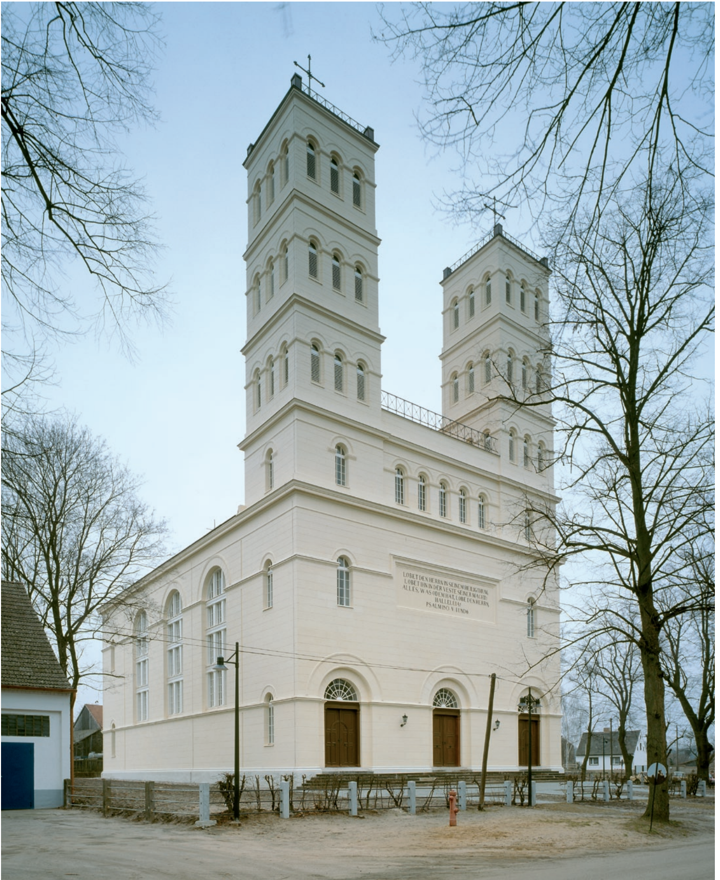
Straupitz (Tšupc; LDS), Dorfkirche. Die Hallenkirche im Rundbogenstil mit zwei quadratischen Ecktürmen nach einem vereinfachten Entwurf Karl F. Schinkels von 1828–32 errichtet. Zuletzt 1992–95 restauriert. Der Sakralbau mit großartiger Fernwirkung gehört zu den Hauptwerken Schinkels im ländlichen Kirchenbau.
