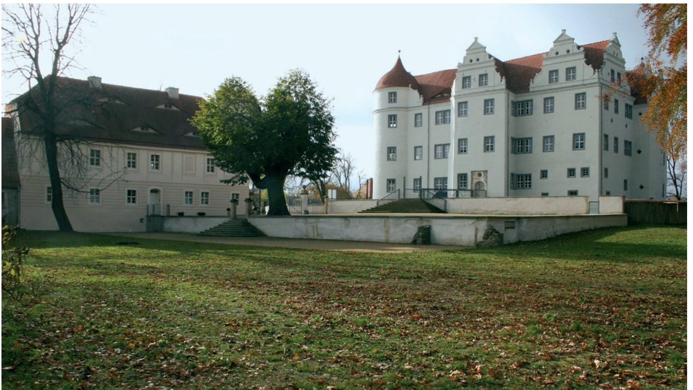
Goldbeck (OPR), Burg. Im Kern wohl 13. Jahrhundert, nach 1548 durch die Adelsfamilie Edle Gans zu Putlitz ausgebaut. Außergewöhnlich vollständig erhaltene ringförmige Burganlage und einer der wenigen mittelalterlichen Adelsitze im ländlichen Bereich.
