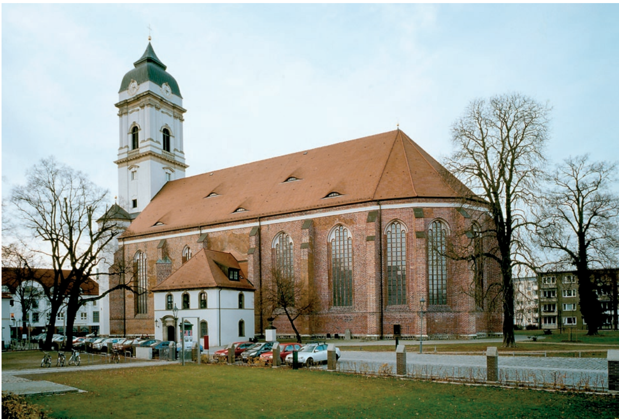
Ziesar (PM), Bischofsburg. Die mittelalterliche Residenz der Brandenburger Bischöfe gehört zu den am besten erhaltenen Burgen eines geistlichen Würdenträgers. Nach umfassender Sanierung und Anbau eines modernen Ausstellungsflügels erfolgte 2005 die Eröffnung als Museum für brandenburgische Kirchengeschichte des Mittelalters.
