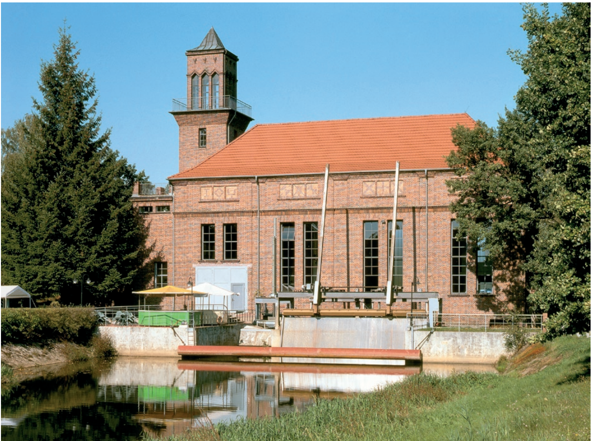
Cottbus (Chósebuz), Am Amtsteich 15, Diesellochwerk mit Schaltheus von 1926–28; architektonischer Entwurf Werner Issel (Baubüro der AEG). Mit dem Kraftwerksbau, besitzt Cottbus ein außerordentlich qualitatives, überregional bedeutendes Zeugnis für die am Neuen Bauen orientierte Industriearchitektur der 1920er Jahre. Seit 2006 Umnutzung zum Kunstmuseum.
