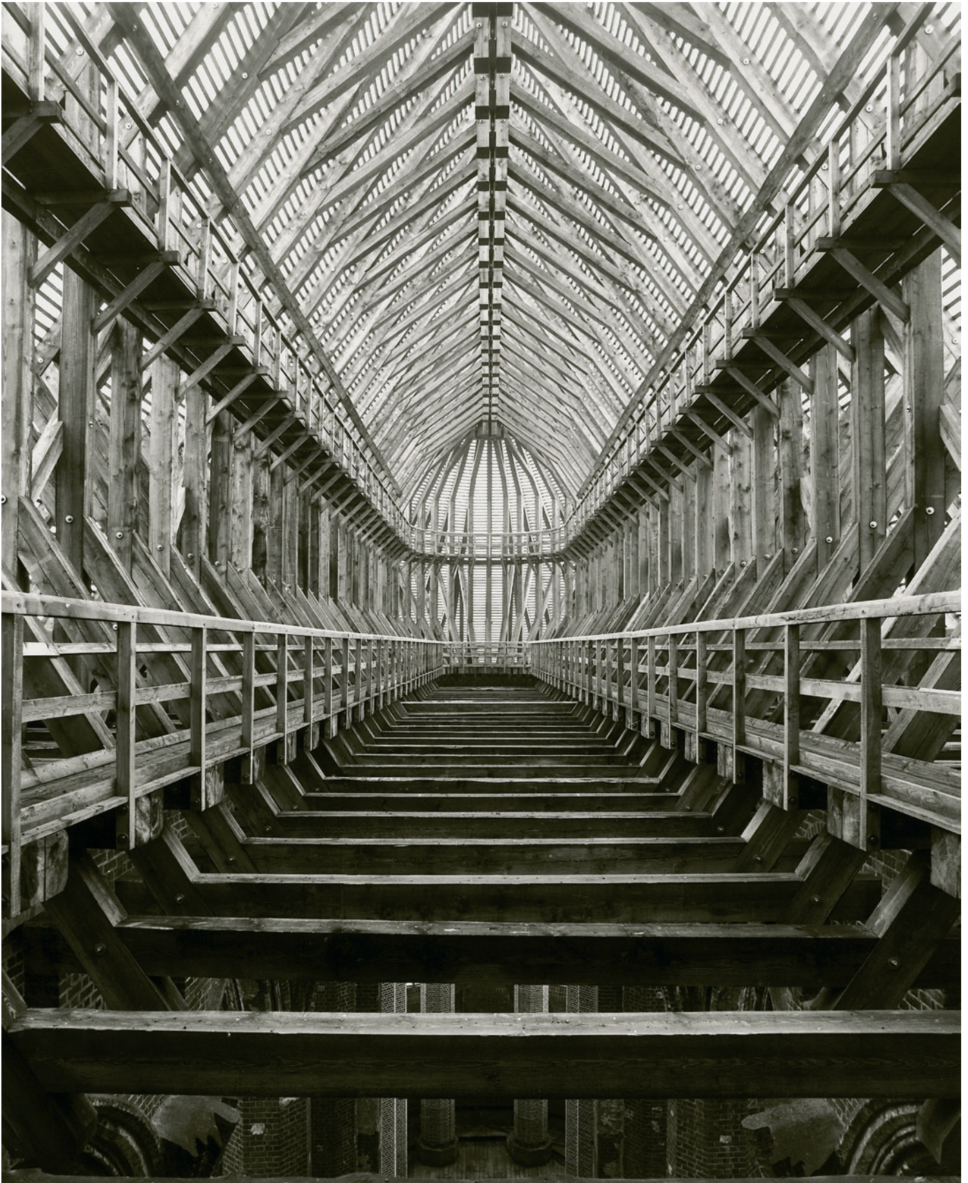
Beeskow (LOS), Pfarrkirche St. Marien (neues Dachwerk). Der beeindruckende neue Dachstuhl wurde 1998/99 unter freier Adaption der großen mittelalterlichen Konstruktionen in Holz ausgeführt. Auch im Kircheninneren raumbildend, da er von Kirchenschiff und Chorraum in ganzer Höhe eingesehen werden kann.
