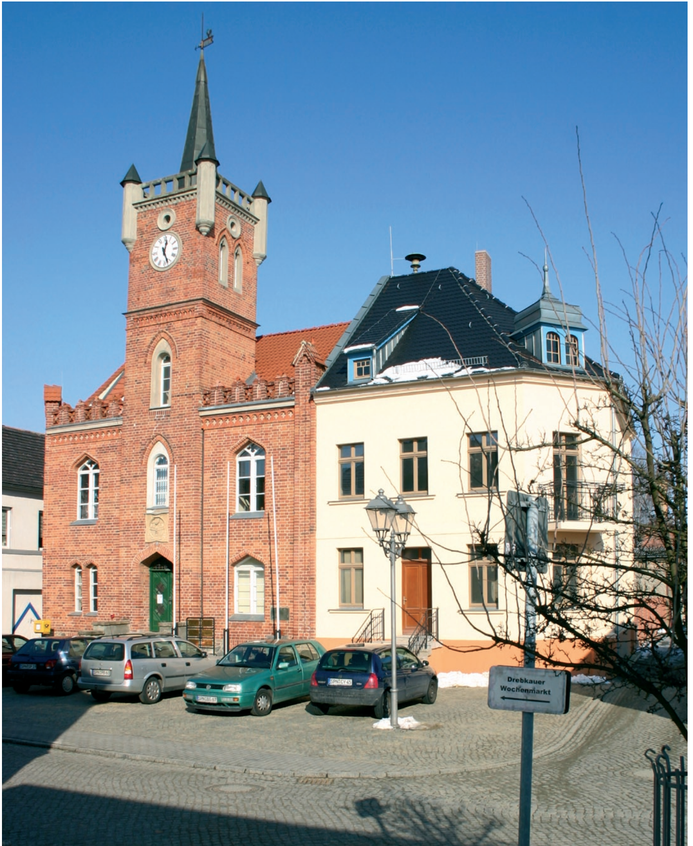
Drebkau (Drjowk; SPN), Rathaus. Kleiner neugotischer Ziegelbau von 1853 im Ortskern. Zweigeschossige Fassade mit abschließendem Zinnenkranz, der eingezogene quadratische Mittelurm mit Spitzhelm und Eckfialen. Gesamtes Gebäude jüngst restauriert.
