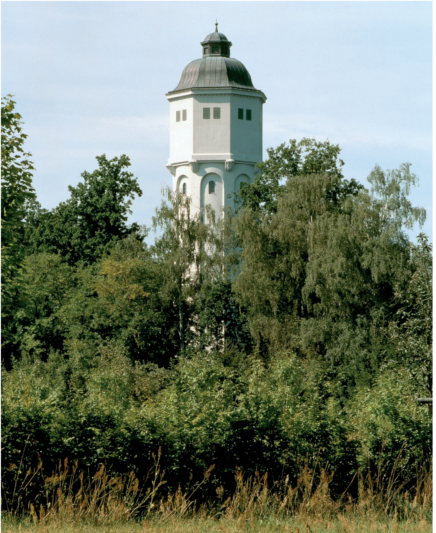
Hohen Neuendorf (OHV), Summter Straße, Wasserturm, 1912–14 von Albert Gottheiner. Das städtebaulich prägnante technische Denkmal wurde in den letzten Jahren umfassend saniert.
