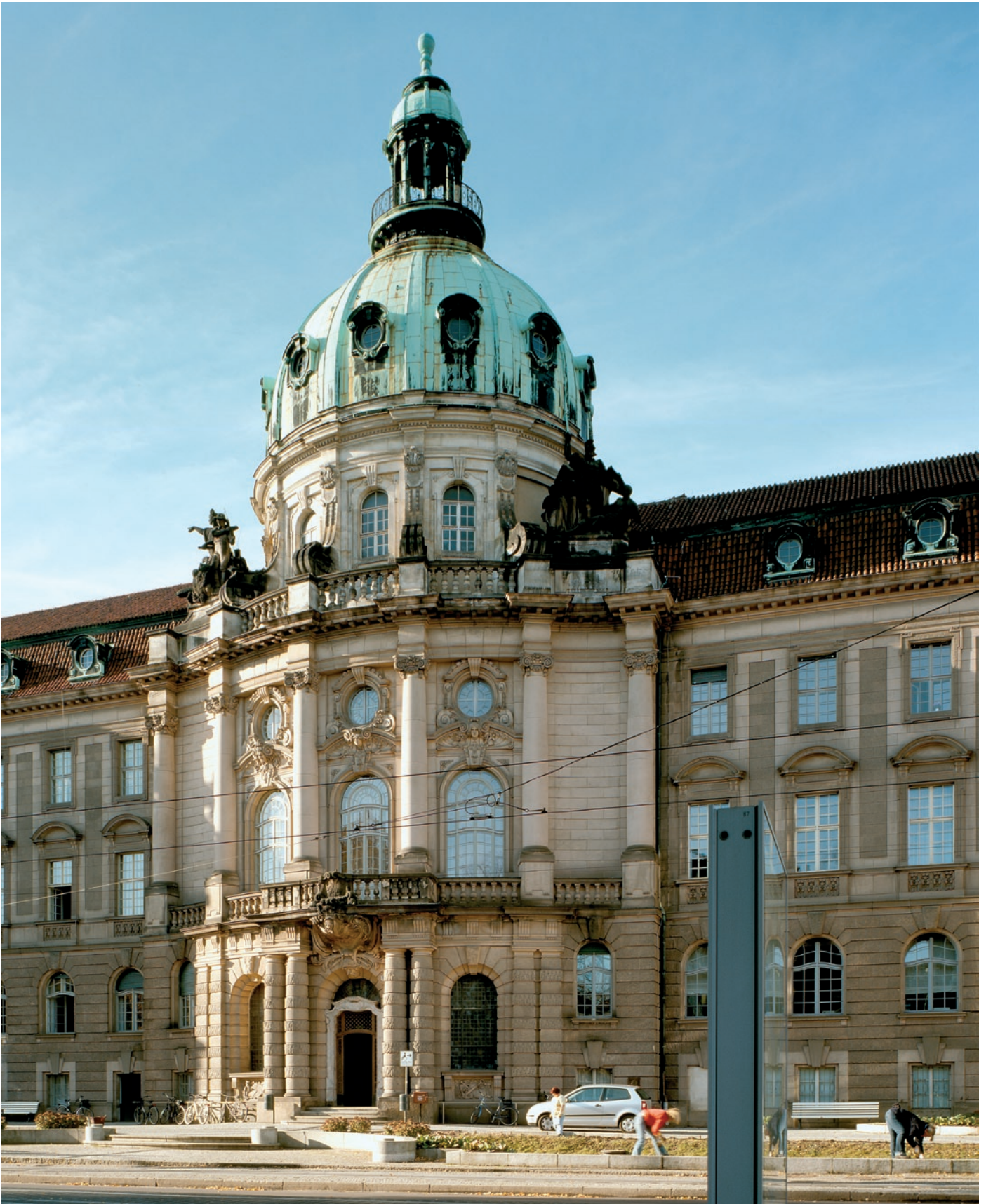
Potsdam, Friedrich-Ebert-Straße 79–81, Regierungsgebäude, jetzt Stadtverwaltung, 1902–08 von Paul Kieschke. Das markante Treppenhaus des um vier Innenhöfe gruppierten Komplexes verdankt seine besondere Wirkung den Stilanleihen bei Rokoko und Jugendstil.
