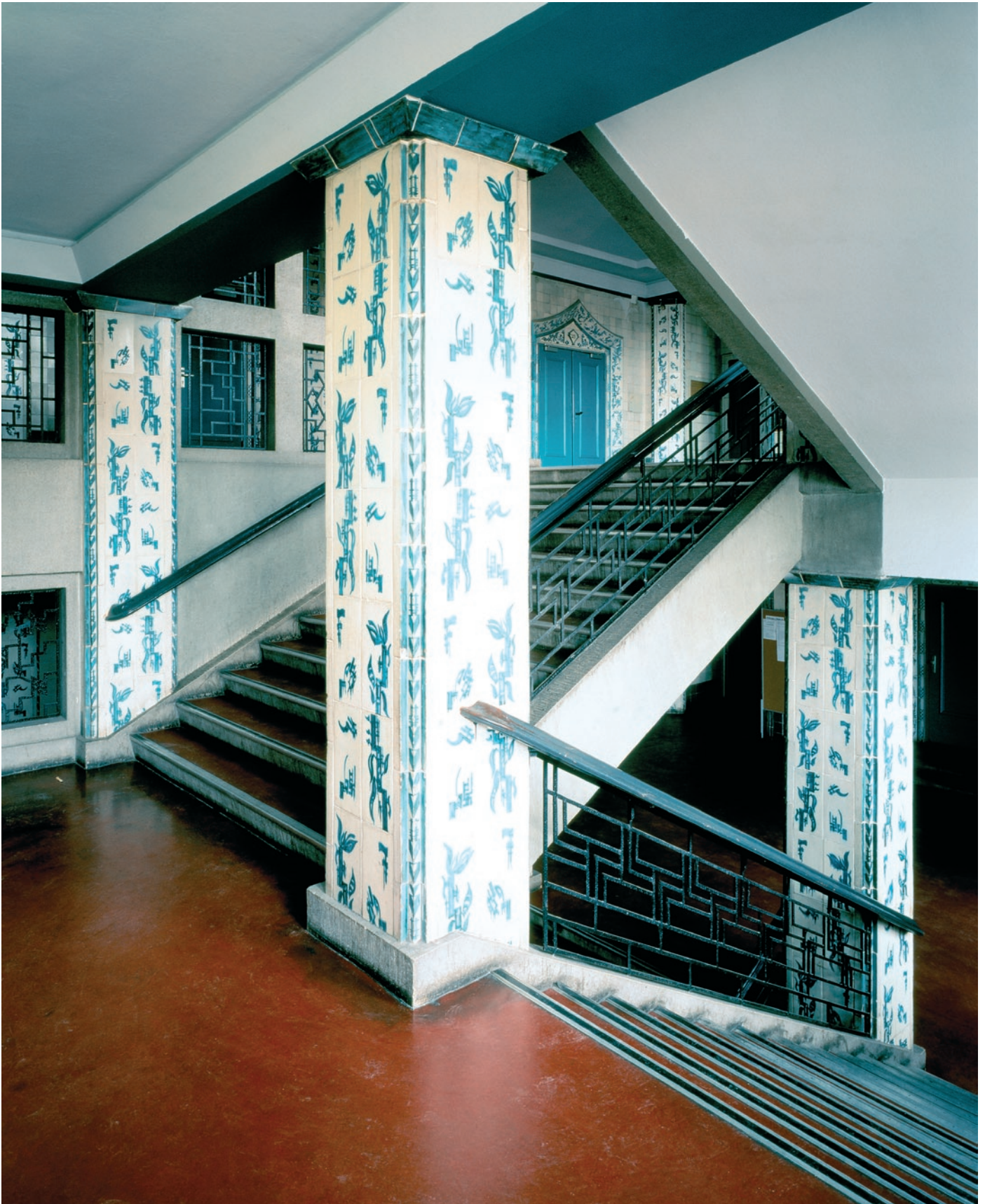
Frankfurt (Oder), August-Bebel-Straße 21, Schule, 1926/27 im Sinne der Reformpädagogik von Stadtbaumeister Josef Gesing errichtet. Von zwei Wohnhausgruppen flankiert, bildet sie den städtebaulichen Mittelpunkt der in den 1920er Jahren entstandenen Nuhen-Vorstadt. Ungewöhnliches Farbkonzept im Innern, Verkleidung der Treppenhaus- und Flurwände mit Fliesen der Rüppurer Fayence Fabrik, Karlsruhe. Die Farbfassung verschiedener Räume 1992/93 wiederhergestellt, Sanierung der Aula 2002.
