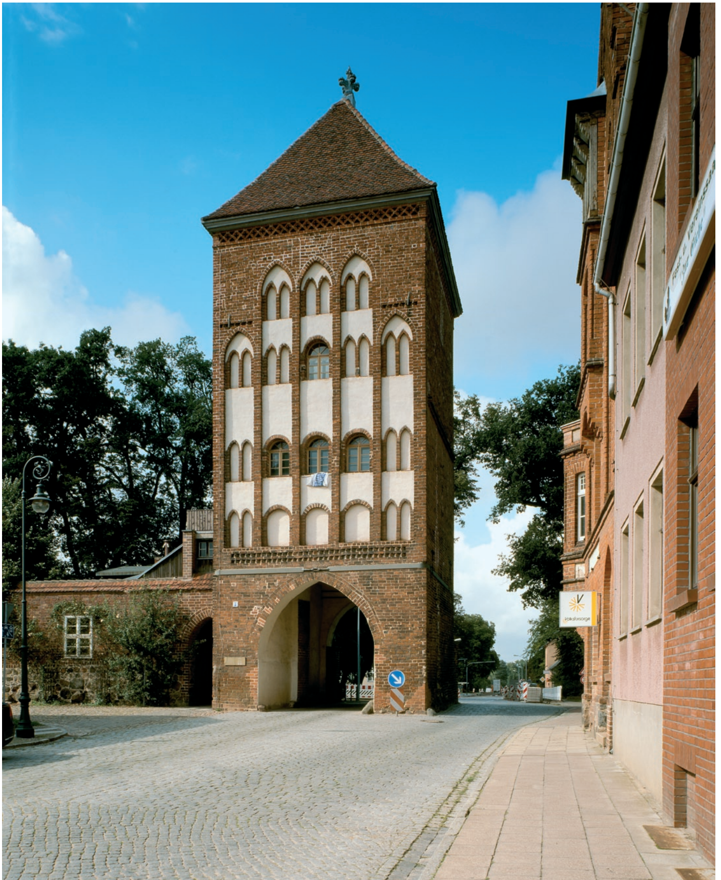
Wittstock/Dosse (OPR), Gröper Tor. Errichtet um 1450 als Teil der Befestigung der einstigen Bischofsstadt; besonders reich geschmückt die »Stadtseite«.
