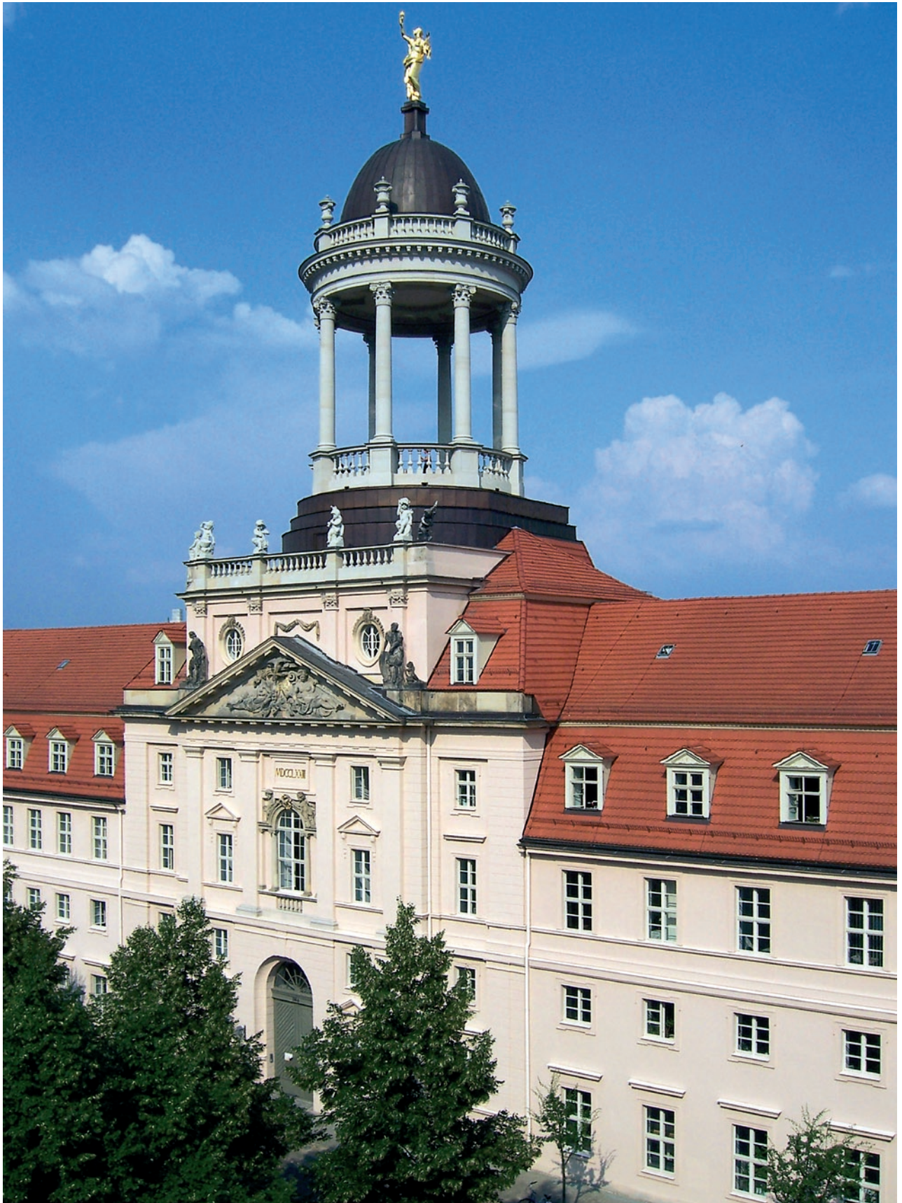
Potsdam, Lindenstraße 34a, Militärwaisenhaus, 1771–78, Karl v. Gontard. Der Mittelpavillon fügt mit dem aufgesetzten Tempietto der Stadtsilhouette einen markanten Bezugspunkt hinzu. 2000–04 Restaurierung der mehrflügeligen Gesamtanlage mit Wiederherstellung des kriegszerstörten Tempelchens.
