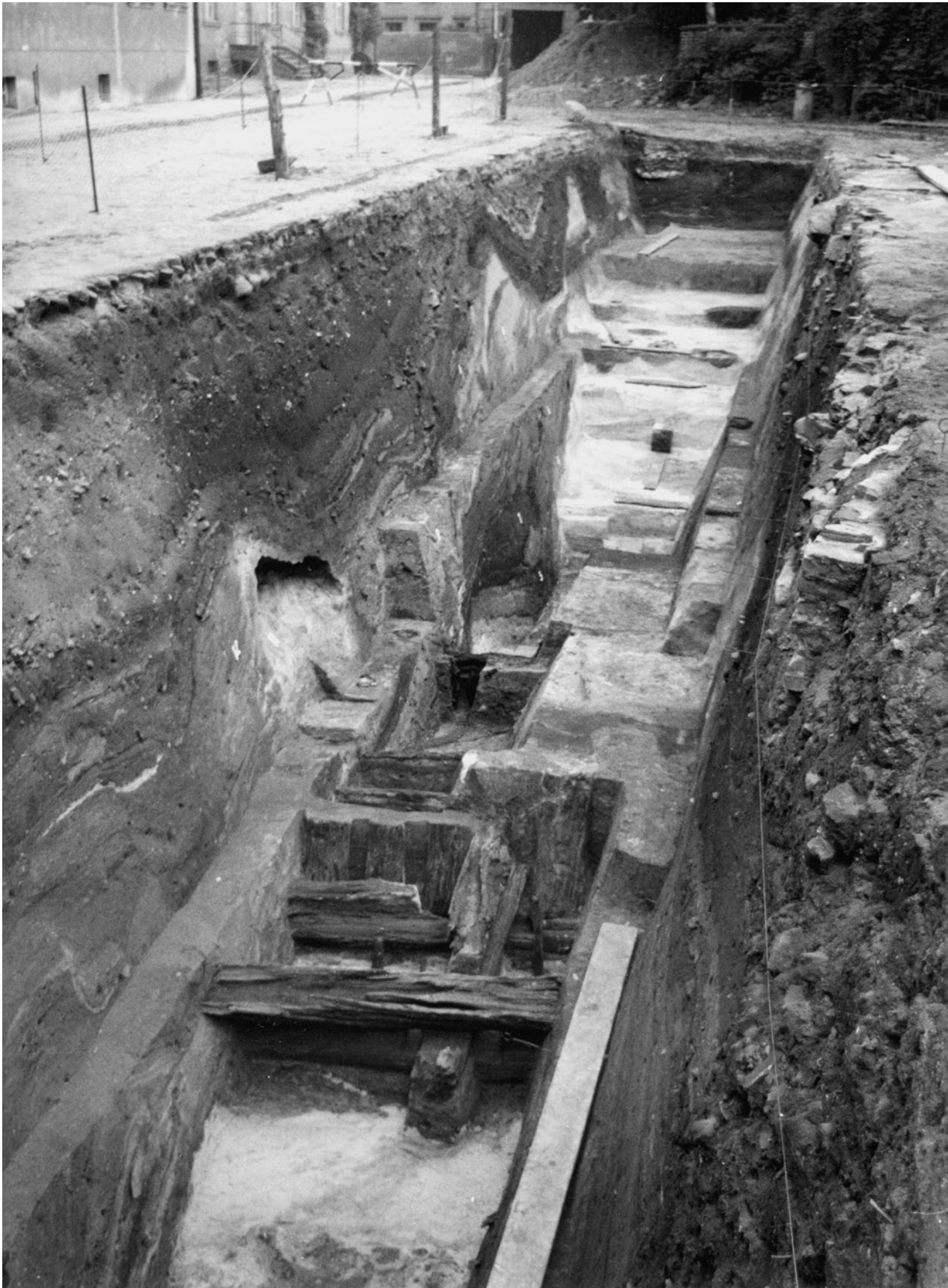
Brandenburg (Havel). Grabungsschnitt aus dem Jahr 1970 an der Petristraße auf der Brandenburger Dominsel mit erhaltenen Holzkonstruktionen der slawischen Buranlage.
