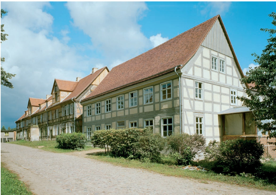
Dahme/Mark (TF), Hospitalkirche. Die 1732–37 durch Johann Ch. Schütze zur Hospitalkirche umgebaute gotische Karmeliter-Klosterkirche wurde 1999/2000 unter Erhaltung historischer Außenputze restauriert.
