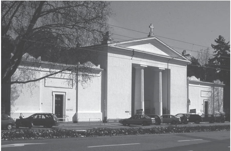
ABB. 11: FRANKFURT AM MAIN, CHRISTLICHER NORDFRIEDHOF (1828), STRASSENANSICHT, ENT- WURF VON F. RUMPF (FOTO: KNUFINKE 2001)
