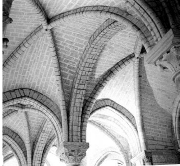
Abb. 40 Rippengewölbe des Chorumgangs
