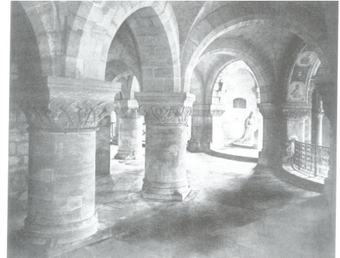
Abb. 36 Kreuzgratgewölbe der Krypta
