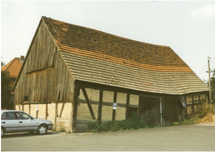
Abb. 90: Friedland: Blockfüll-Scheune von 1774 aus der Ordensamts-Zeit
