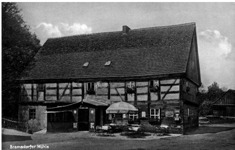
Abb. 88: Alte Bremsdorfer Mühle mit Blockstuben-EG und Fachwerk-OG, um 1810
