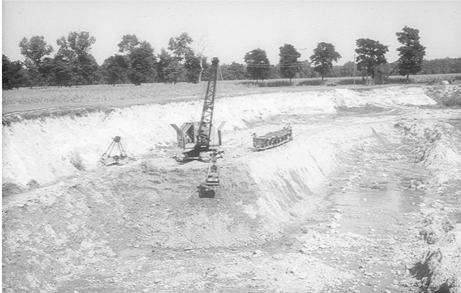
Foto 4.2.1 Zwei bis vier Meter mächtige, nach Norden abgelagerte weichselkaltzeitliche Schmelzwassersande, die von Dezimeter mächtigen Niedertaukiesen unterlagert werden. Diese bedecken 2 bis 5 m starken bröckligen graubraunen weichselkaltzeitlichen Geschiebemergel. Ehemalige Abbaugrube Ziegelei Kranepuhl, Wasserhaltung. Oberkante der Niederung in 30 - 31 m NN (Aufnahme Juni 1971)
