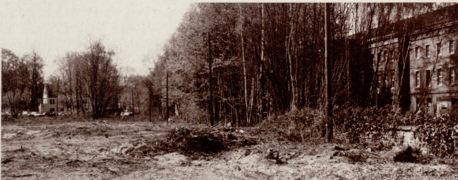
Noch Baufeld: Später Hörsäle und Seminarräume.
