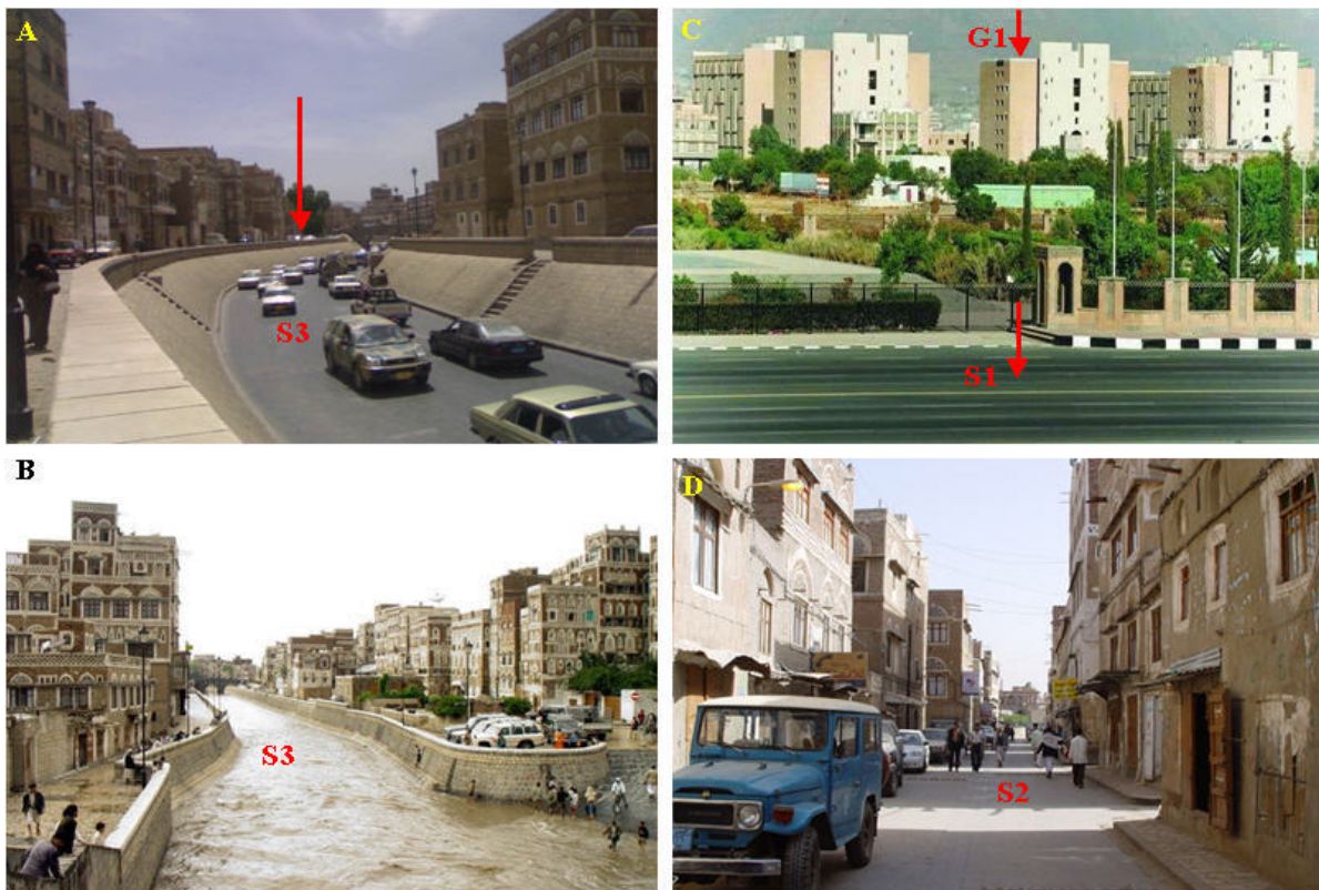
Abb. 6.2.1-4: Straßenstrukturen und Baumaterialien: A) Kanal aus Asphalt genutzt als Straße; B) Kanal führt Wasser; C) mehrspurige Asphaltstraße D) Pflasterstraße in der Altstadt Quellen: Bild A von Mofadhl Y., Bild B von Aljadaby A., Bild C von Alhameedy, Bild D von Urbanalyst. Eigene Darstellung.
