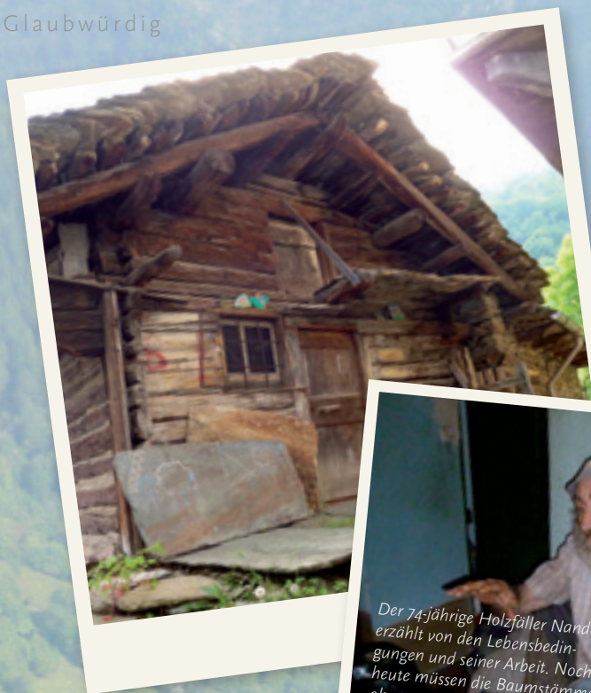
Walserhaus in San Gottardo. Die vorspringenden Steinplatten dienen als Schutz gegen Mäuse, eine der Schieferplatten wurde von Kindern als Tafel benutzt.
