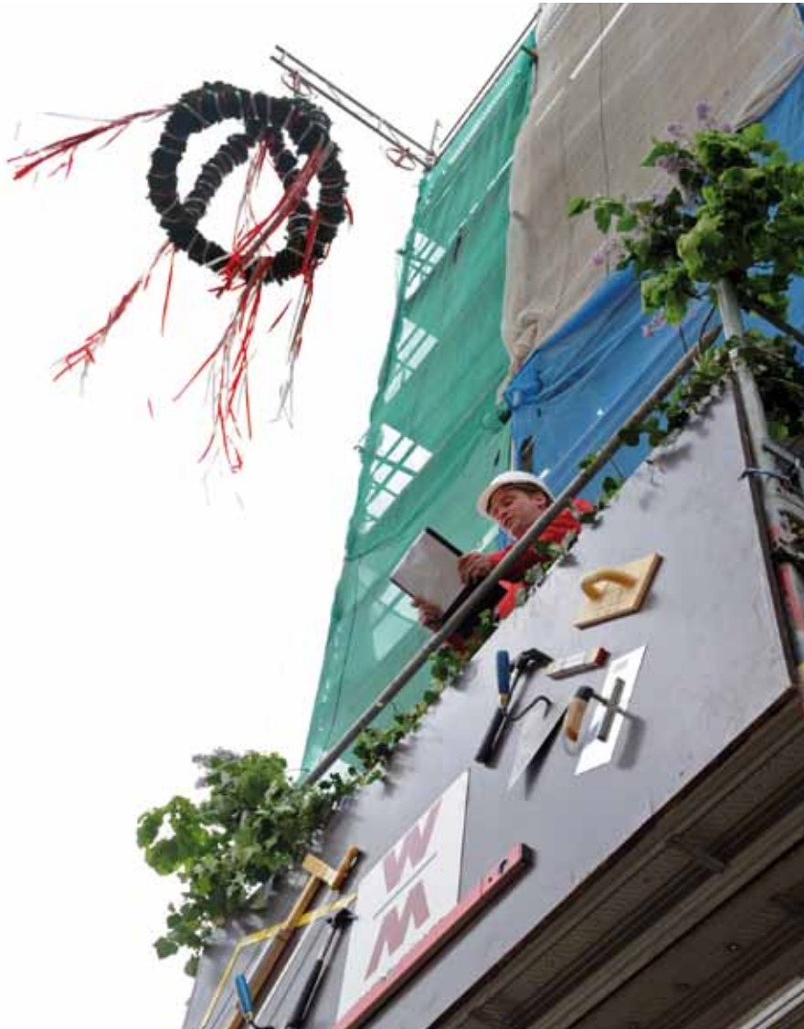
Richtkronen über dem Bibliotheksneubau: Künftig Platz für eine Million Bücher.
