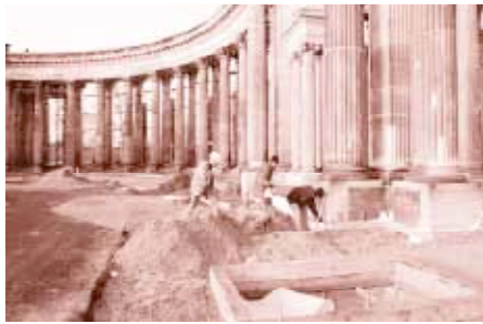
2012 wieder begehbar: Die Kolonnade zwischen den beiden Communs.
