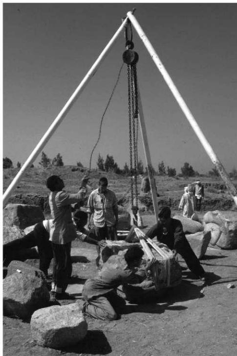
Arbeiter fügen mit Hilfe eines Dreibocks zwei Steinfragmente zusammen
