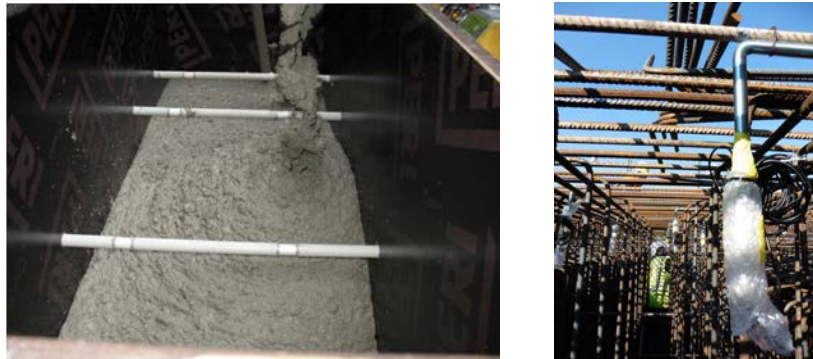
Abbildung 4.12: Das Montieren der Ultraschallprüfköpfe an die Verschalung (links) und an die Bewehrung (rechts).
