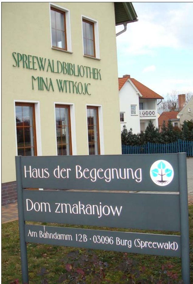
Haus der Begegnung mit der nach der sorbischen (wendischen) Dichterin Mina Witkojc/Wilhelmine Wittka benannten Spreewaldbibliothek in Burg (Spreewald)/Bórkowy (Błota)
