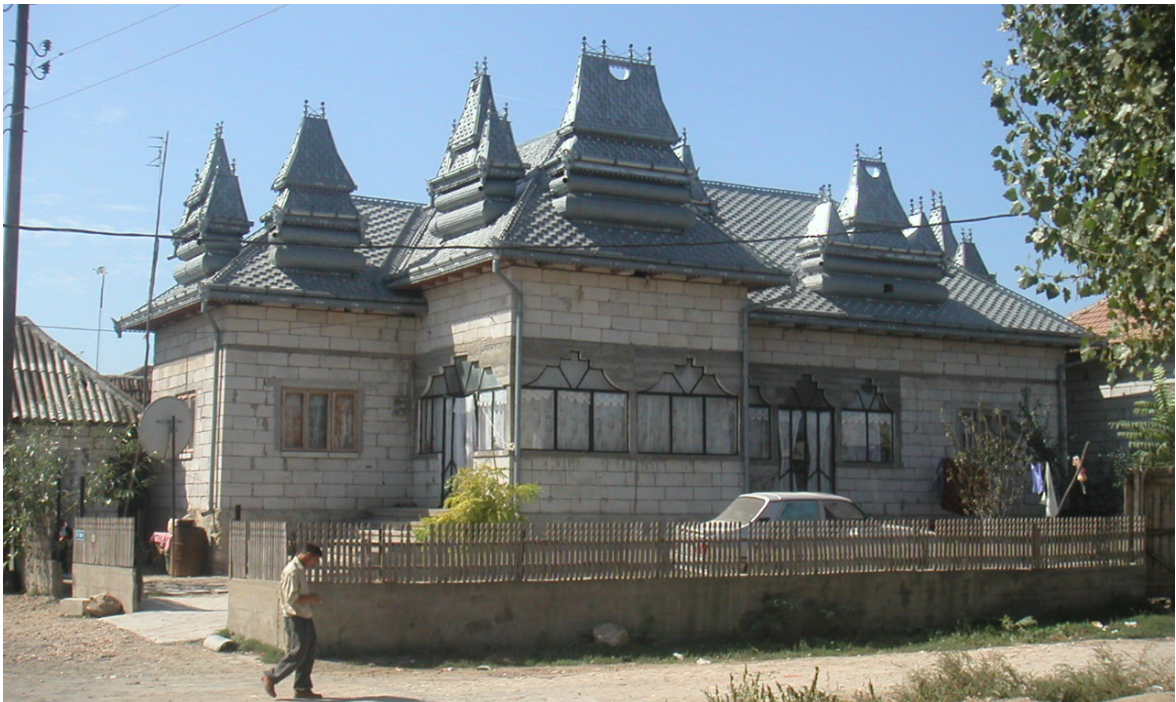
Foto 38: Wohnhaus von Căldărari-Roma in Cuza Vodă Fotos: J. Sallanz 2004
