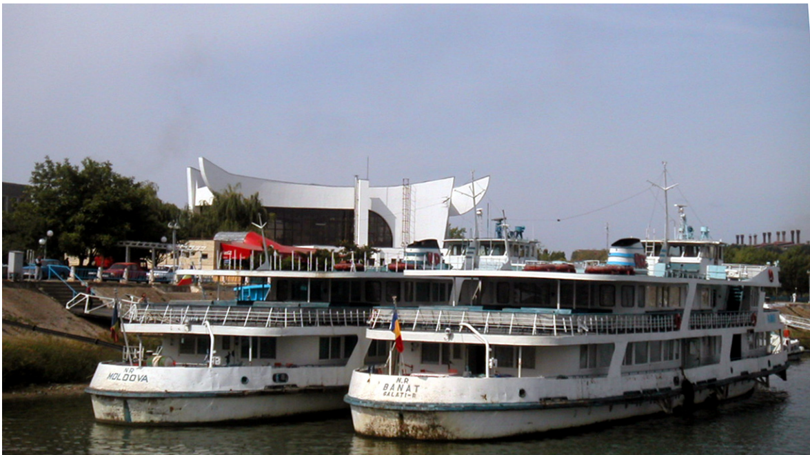
Foto 5: Tulcea – Bahnhofsgebäude (im Hintergrund) und Schiffsanlegestelle Foto: J. Sallanz 2004
