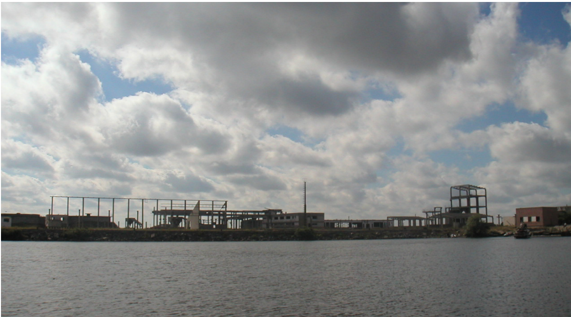
Foto 20: Caraorman – Bauruinen einer Fabrik Fotos: J. Sallanz 2004
